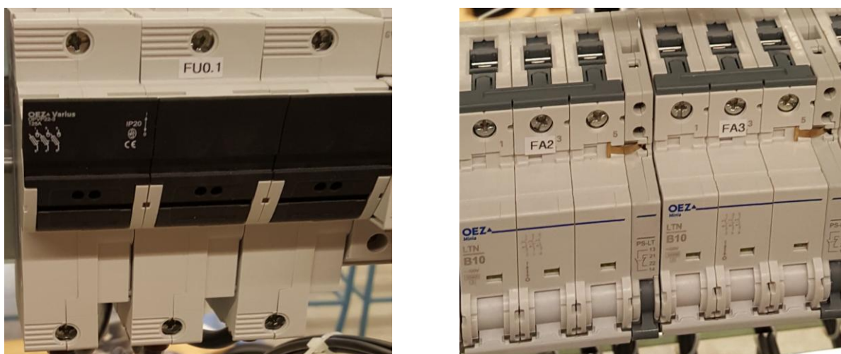
Obrázek 3.5: Popsané přístroje štítky
