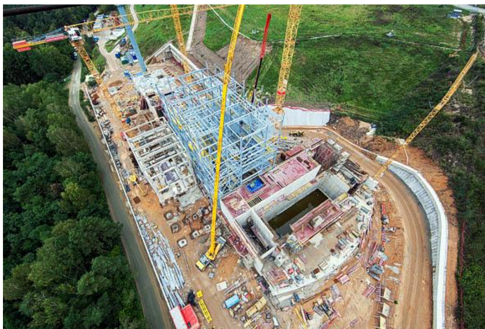
Obr. 5 - Stavební práce (převzato z [14])
