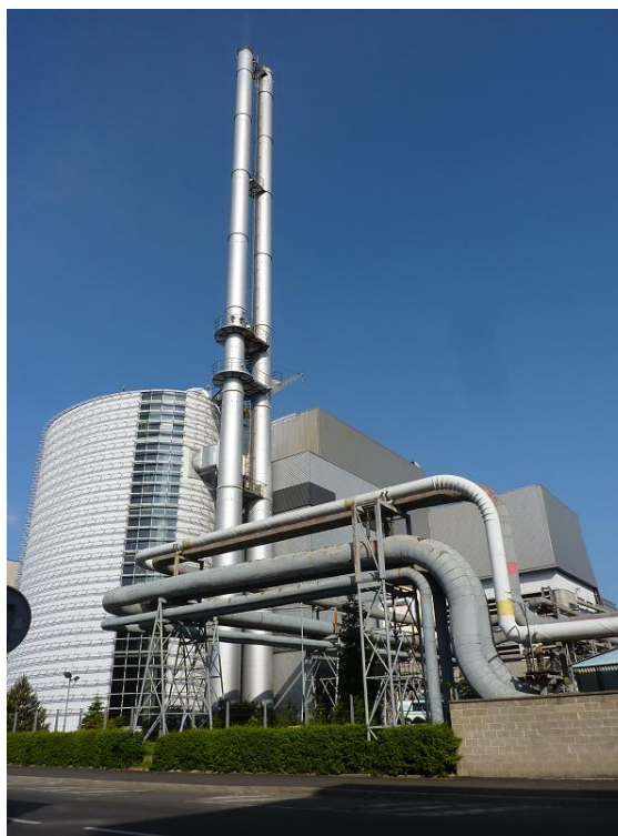
Obr. 16 – Spalovna Termizo, a.s. (převzato z [44])
