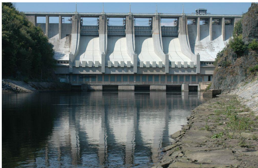
Obr. 15. Vodní elektrárna Slapy (převzato [20])
