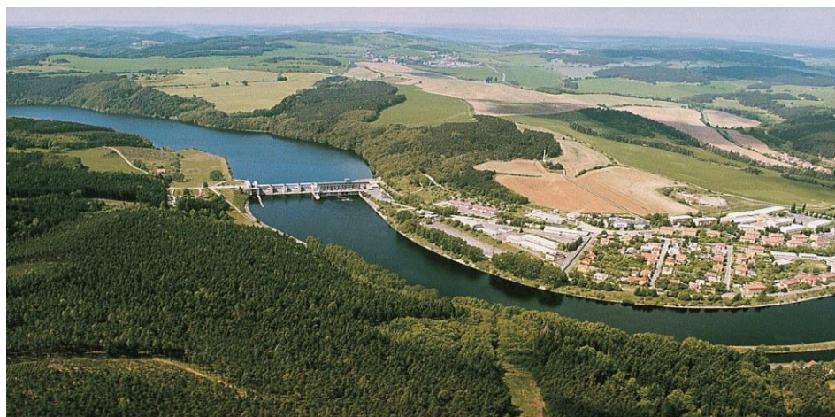
Obr. 12. Vodní elektrárna Kamýk (převzato [20])
