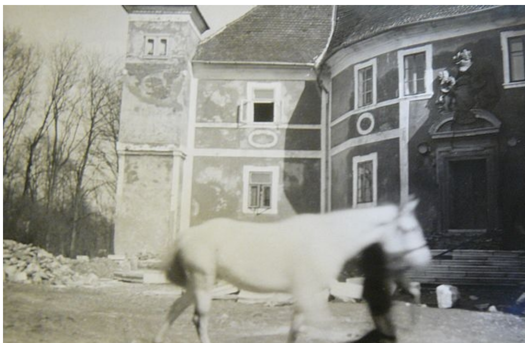
Obrázek 91: Částečně dokončené úpravy hlavního vstupu. Po roku 1920. Zdroj: SOA Plzeň. Fond: Coudenhove - Kalergi. Neroztříděný fond, bez inv. č.
