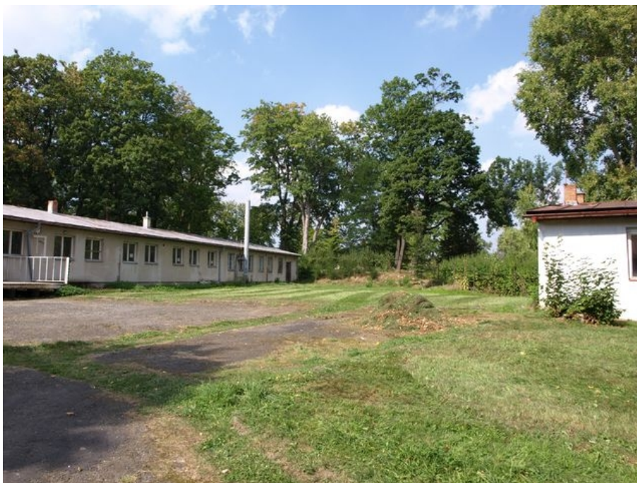
Obrázek 114: Severní pohled. 2016. Zdroj: vlastní
