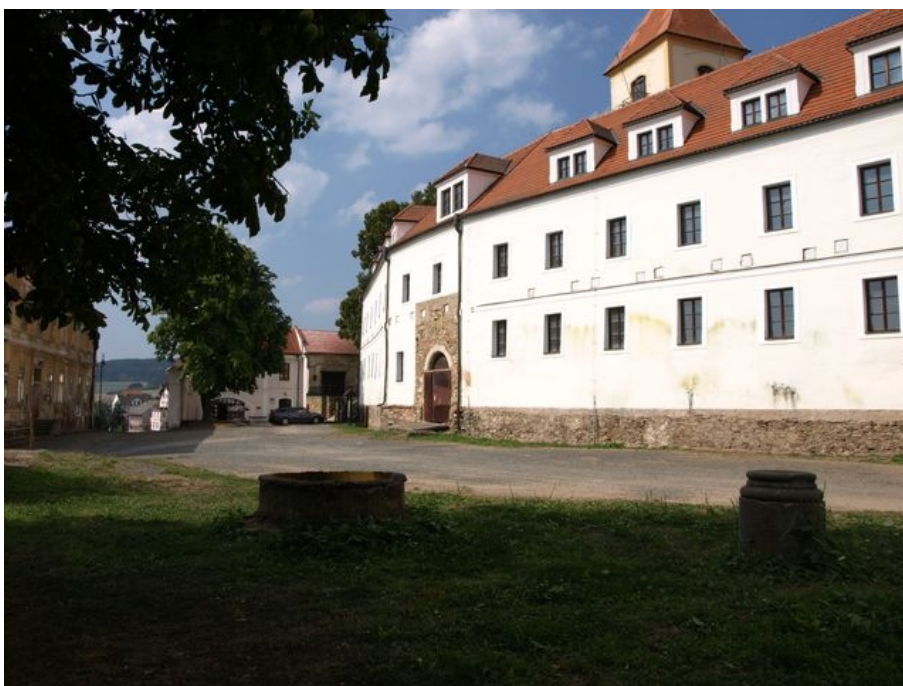
Obrázek 102: Východní pohled na hospodářské křídlo. 2016. Zdroj: vlastní
