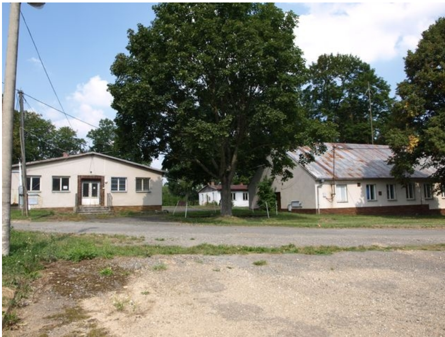
Obrázek 112: Pohled na areál bývalé roty od jihu. 2016. Zdroj: vlastní
