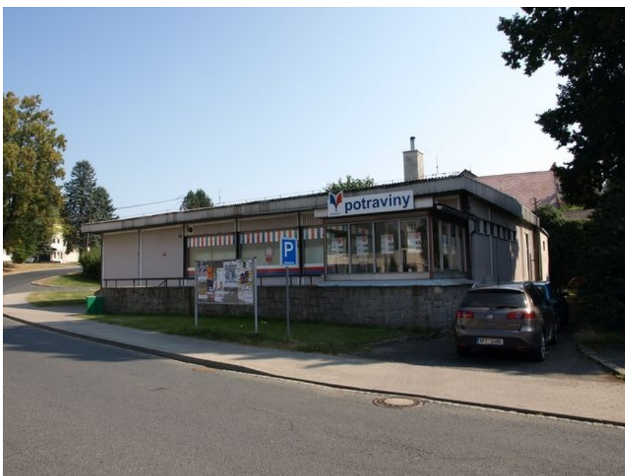
Obrázek 83: Objekt samoobsluhy č.p. 66. Jihozápadní pohled. 2016. Zdroj: vlastní
