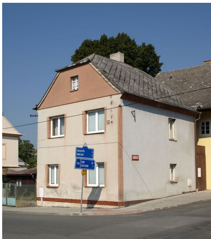
Obrázek 75: Severozápadní průčelí domu č.p. 35 na náměstí Míru. 2016. Zdroj: vlastní
