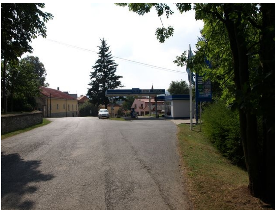
Obrázek 82: Severní pohled na areál čerpací stanice pohonných hmot č.p. 281. 2016. Zdroj: vlastní
