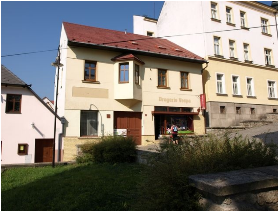
Obrázek 68: Dům č.p. 48. Pohled od východu. U domu jsou patrné schodiš- tové terasy. 2016. Zdroj: vlastní
