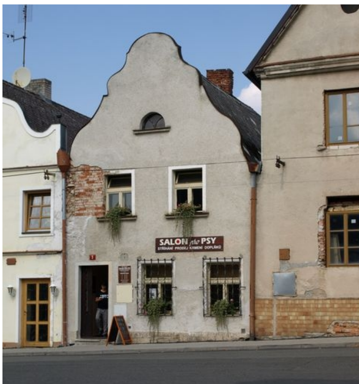
Obrázek 58: Jižní průčelí domu č.p. 3 na náměstí Míru. 2016. Zdroj: vlastní
