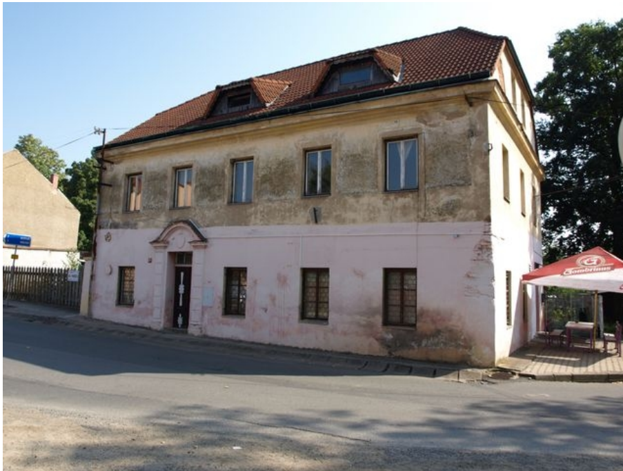
Obrázek 33: Pohled od západu na dům č.p. 129 ve Slovanské ulici. 2016. Severní zeď domu je postavena na hradbě městského opevnění. Zdroj: vlastní.
