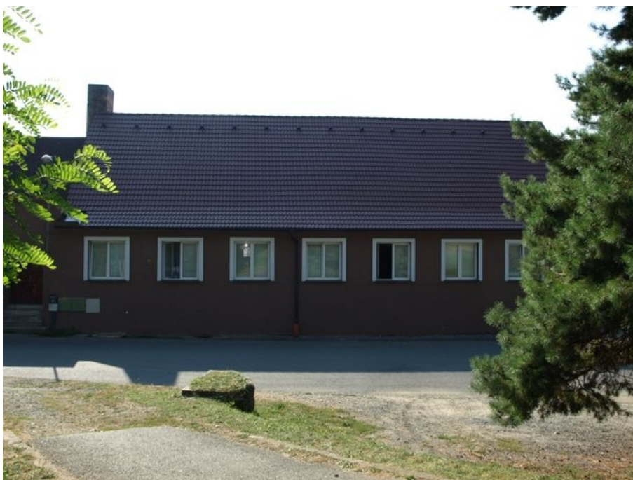
Obrázek 38: Uliční průčelí domu č.p. 35. Zcela nevhodné řešení pro MPZ. 2016. Zdroj: vlastní
