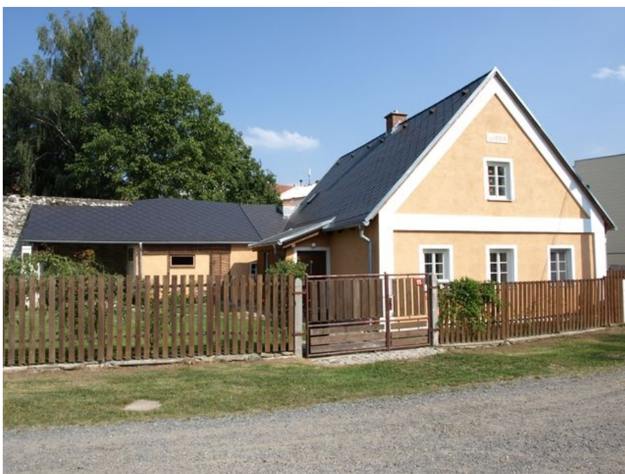
Obrázek 15: Č.p. 125, pohled od jihu. Za přístavkem je patrná zeď městského opevnění. Zde nezachycený severovýchodní roh je umístěn na bývalé baště. Zdroj: vlastní
