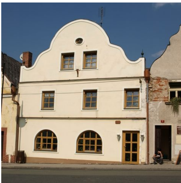
Obrázek 57: Jižní průčelí domu č.p. 4 na náměstí Míru. 2016. Zdroj: vlastní
