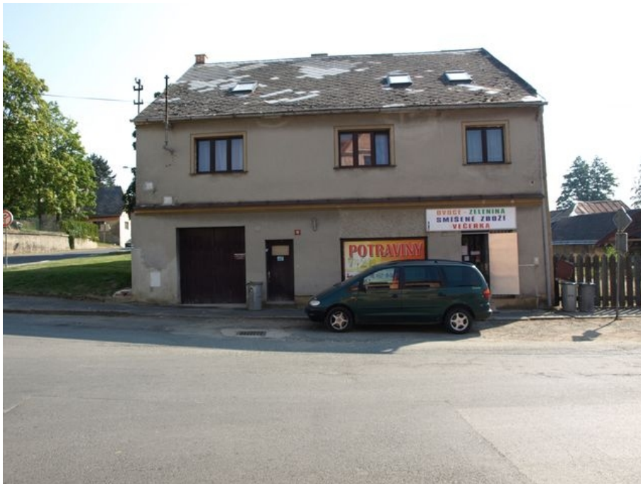
Obrázek 34: Západní uliční průčelí domu č.p. 30. Slovanská ulice. 2016. Zdroj: vlastní.
