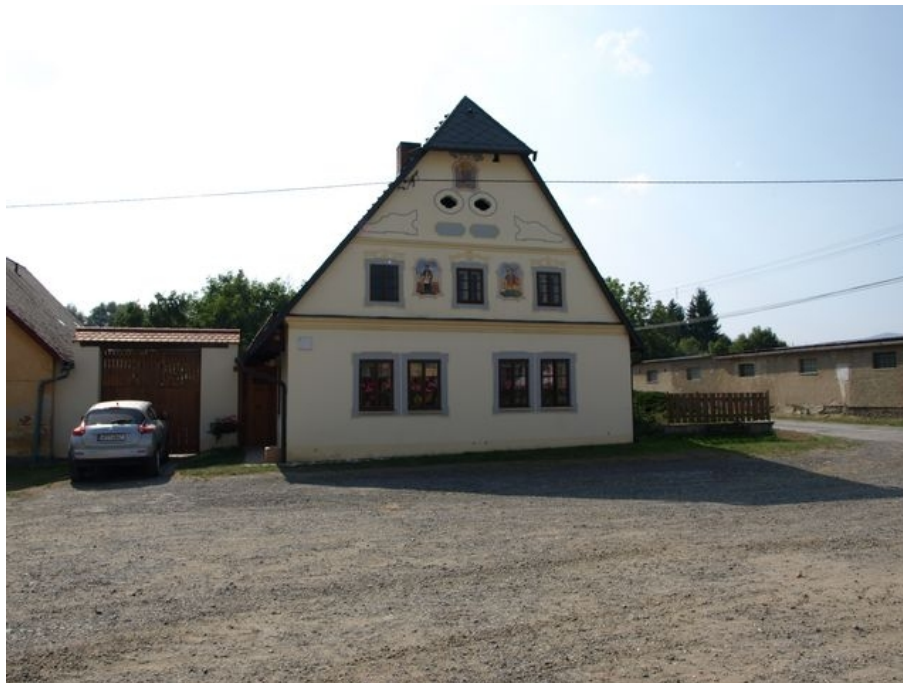
Obrázek 11: Dům č.p. 138 Spojenecké náměstí, pohled od severu. 2016. Zdroj: vlastní
