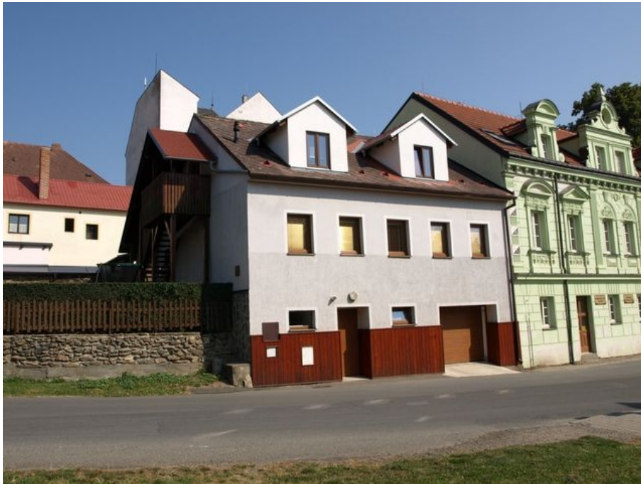
Obrázek 66: Dům č.p. 51 v pohledu od jihu. Nápadná je nečleněná fasáda. 2016. Zdroj: vlastní
