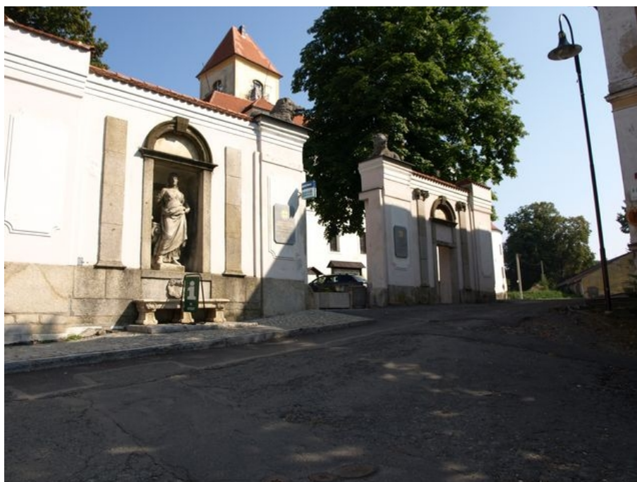
Obrázek 104: Vstupní brána. Pohled od jihu. 2016. Zdroj: vlastní
