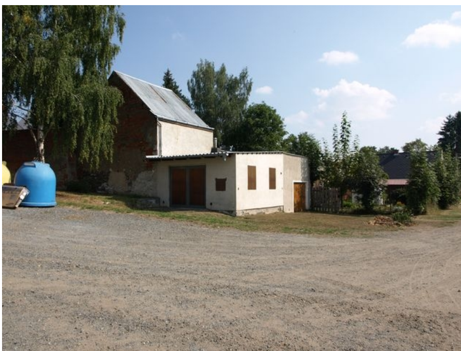
Obrázek 19: Garáže na pozemku 280/2 a 281/2. Vzadu je patrná starší stodůlka u domu č.p. 19. Mezi stodolou a garáží probíhá zeď městského opevnění. 2016. Zdroj: vlastní.
