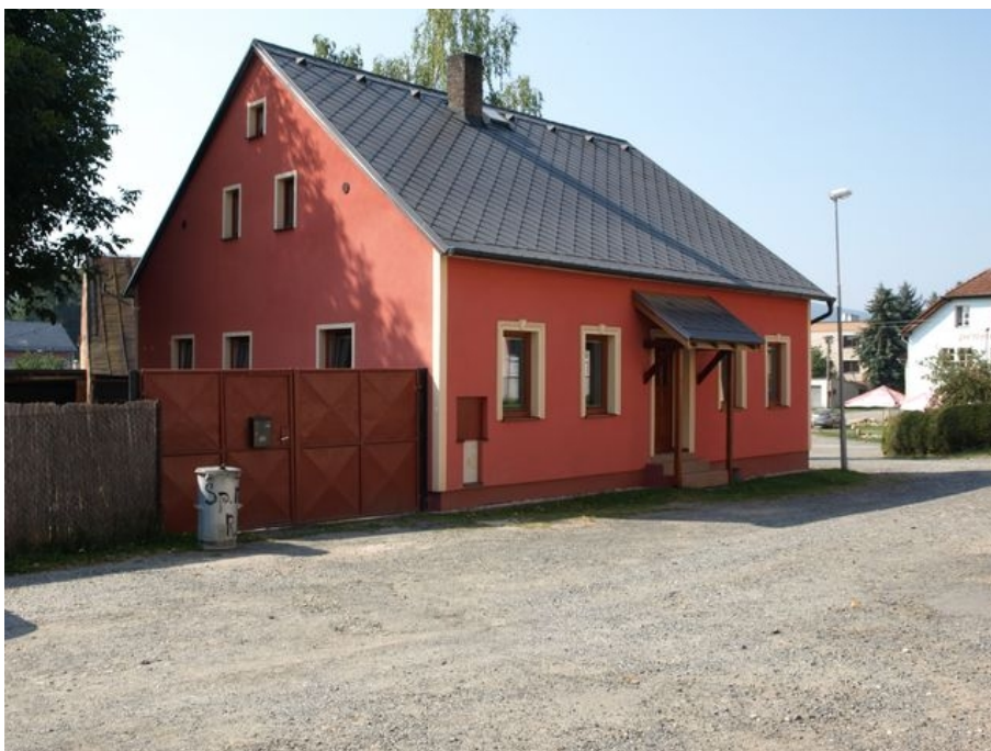
Obrázek 20: Severovýchodní pohled na uliční průčelí domu č.p. 19. Původní vzhled domu byl zcela setřen kontaktním zateplením. 2016. Zdroj: vlastní.
