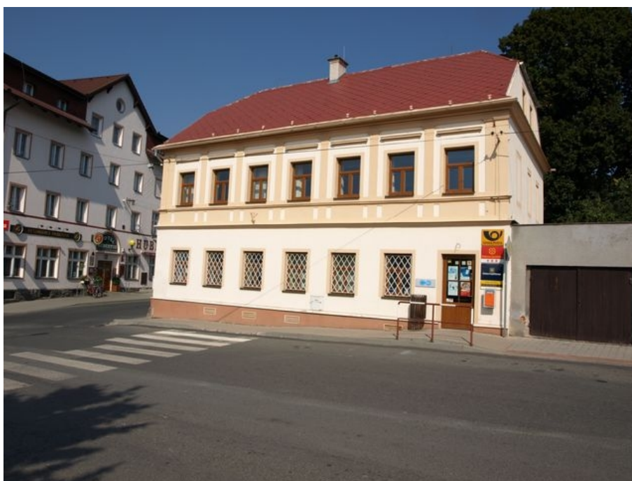
Obrázek 84: Jižní pohled na objekt pošty č.p. 67. V levé části je vidět hotel Hubertus, který leží mimo hranice MPZ. 2016. Zdroj: vlastní
