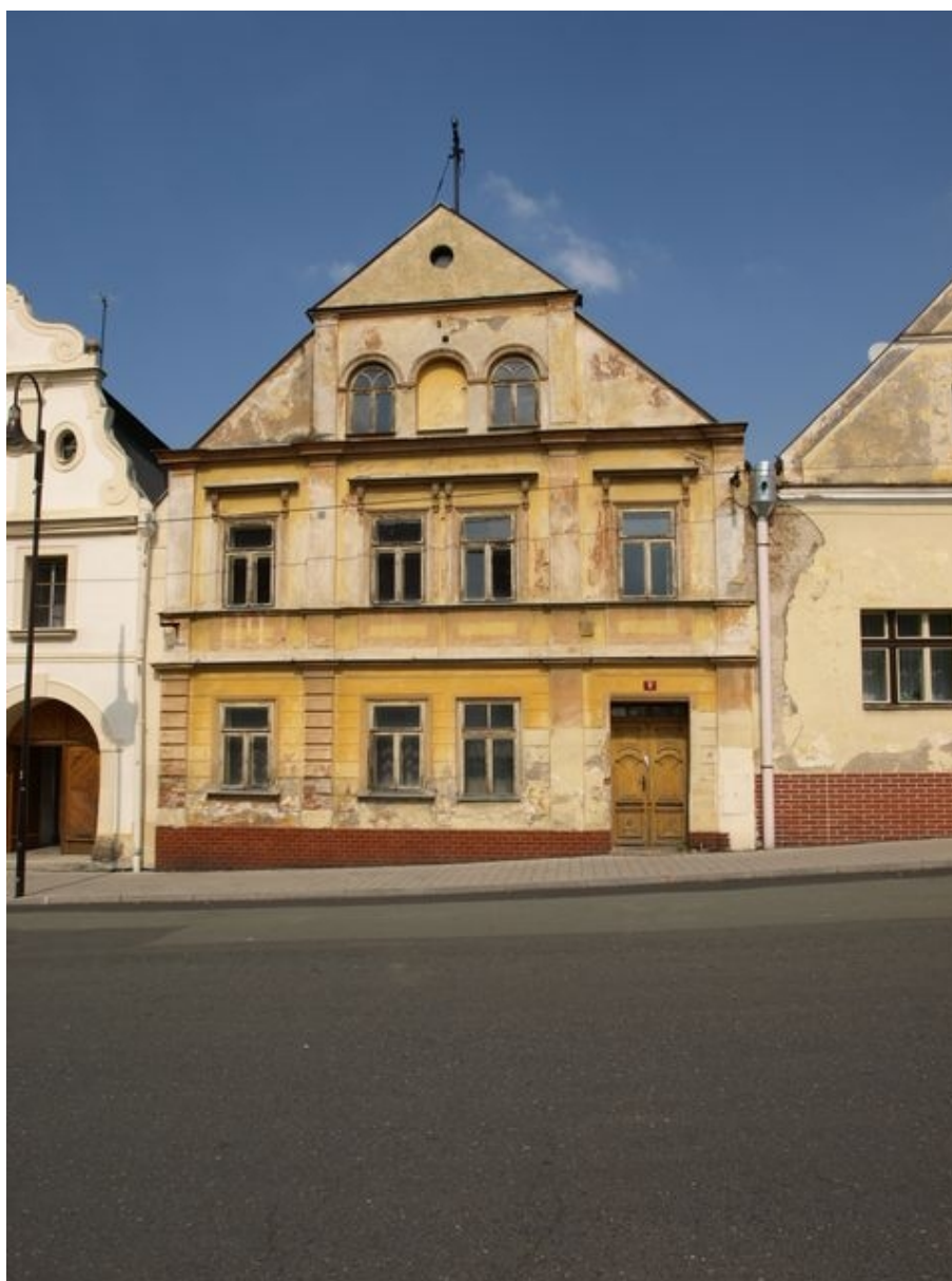
Obrázek 51: Jižní průčelí domu č.p. 6 na náměstí Míru. Jedná se o jeden z nejcennějších objektů v MPZ Poběžovice. 2016. Zdroj: vlastní
