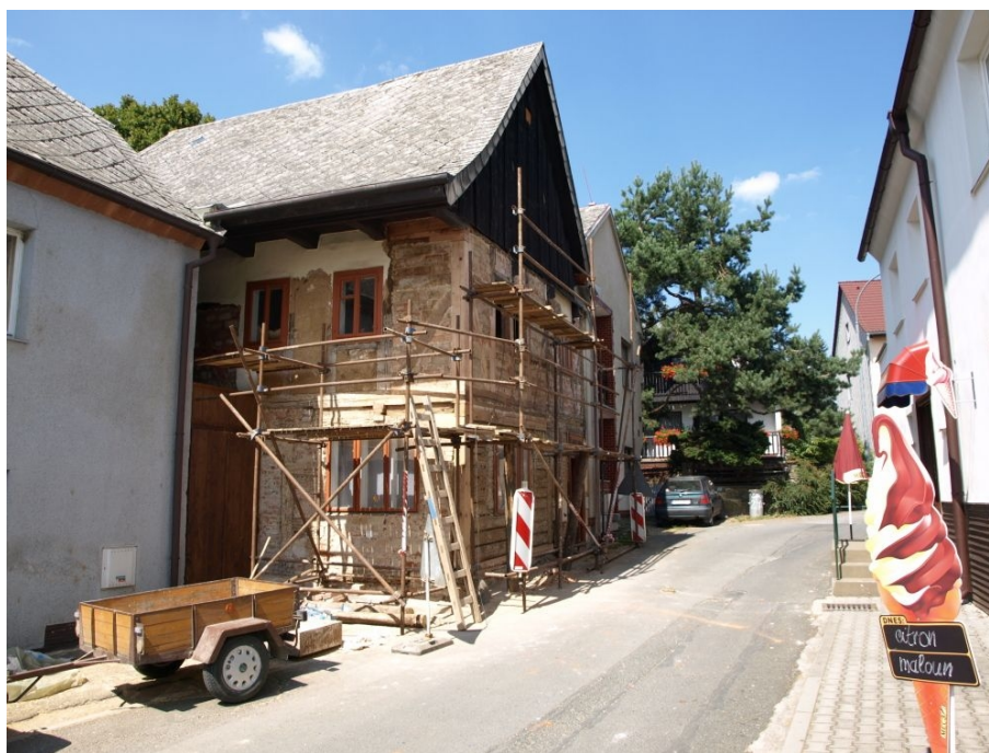
Obrázek 73: Dům č.p. 64 během rekonstrukce. Je vidět roubené přízemí a hrázděné patro. 2013. Zdroj: vlastní
