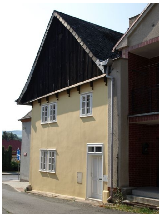
Obrázek 77: Dům č.p. 64 po rekonstrukci. 2016. Zdroj: vlastní
