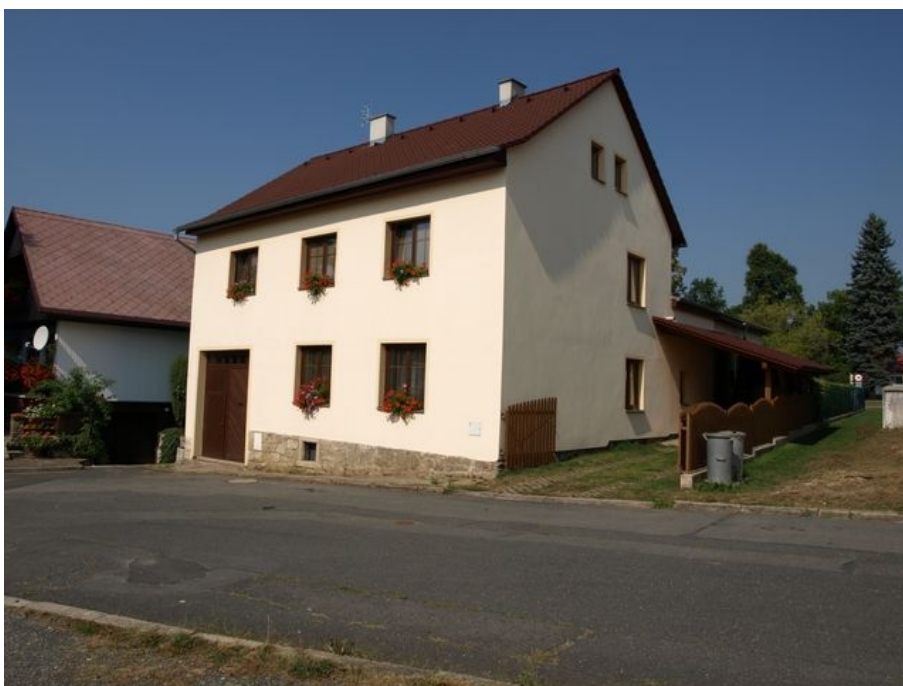
Obrázek 80: Jižní průčelí domu č.p. 62, Šandova ulice. 2016. Zdroj: vlastní
