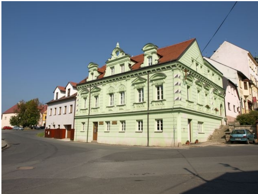
Obrázek 67: Zdařilá oprava domu č.p. 50. Pohled ze Slovanské ulice. 2016. Zdroj: vlastní
