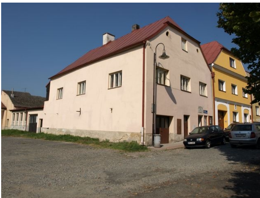
Obrázek 26: Jihozápadní nároží domu č.p. 15. Směrem na jih stál dům č.p. 16, který uzavíral uliční frontu. 2016. Zdroj: vlastní.
