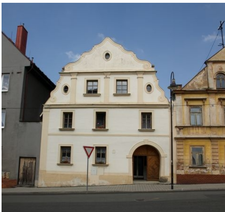
Obrázek 50: Jižní průčelí domu č.p. 7 na náměstí Míru. 2016. Zdroj: vlastní
