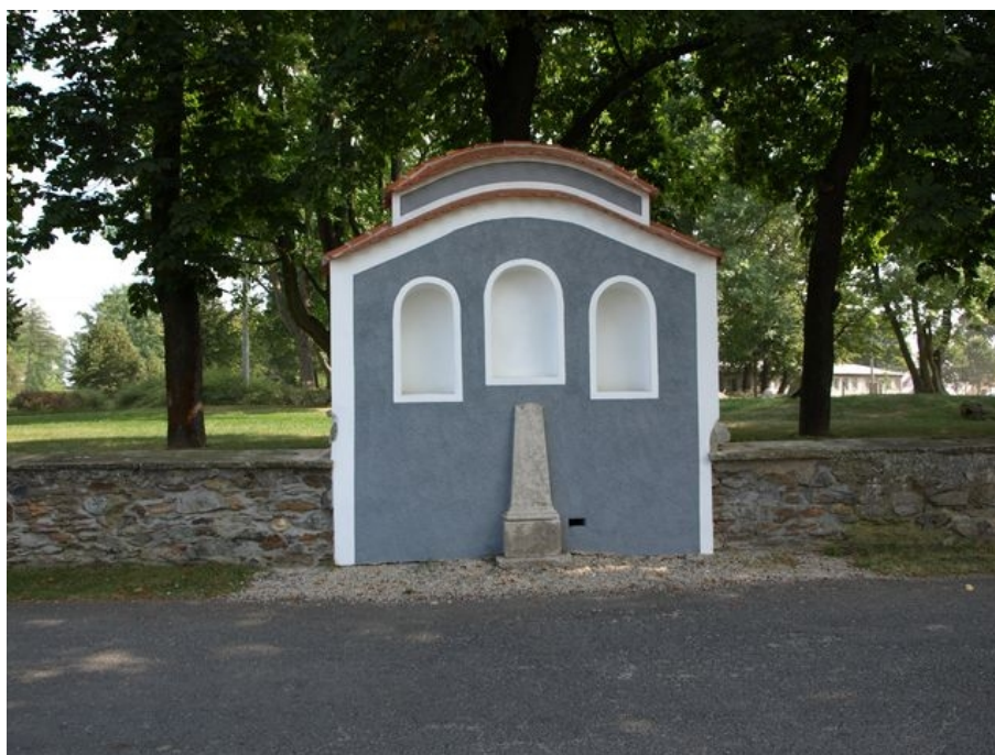
Obrázek 108: Kaplička po dokončené opravě z roku 2015. 2016. Zdroj: vlastní
