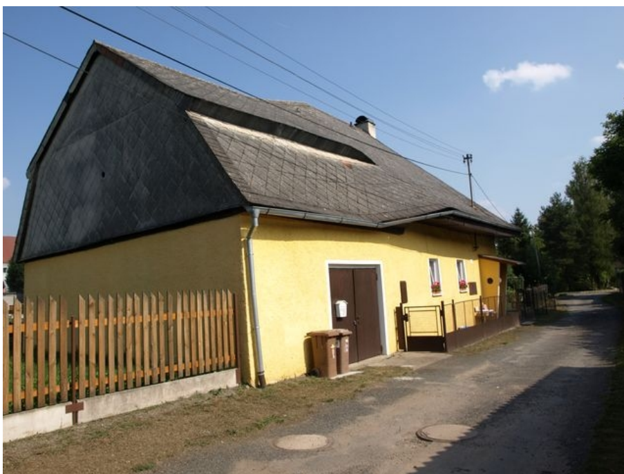
Obrázek 17: Dům č.p. 222, jižní pohled. 2016. Na domě je dobře viditelný zlom ve střešním plášti. Mansardová střecha je pravděpodobně starší. Zdroj: vlastní.
