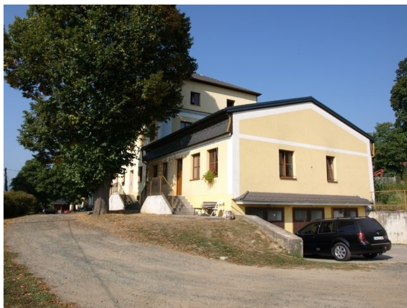
Obrázek 42: Kotelna u domu č.p. 202. 2016. Zdroj: vlastní.
