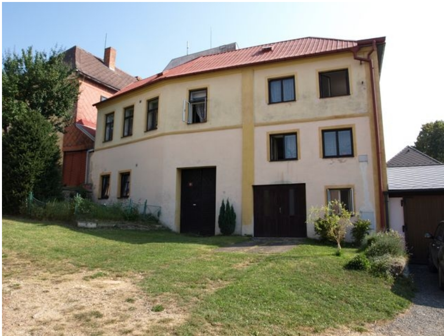
Obrázek 65: Západní průčelí domu č.p. 53. Vnitřní blok náměstí Míru. Vpravo od domu je vidět část zástavby zahrady u domu č.p. 49. 2016. Zdroj: vlastní
