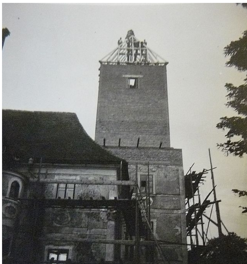
Obrázek 89: Stavba věže. Po roce 1920. Zdroj: SOA Plzeň. Fond: Coudenhove - Kalergi. Neroztříděný fond, bez inv. č.
