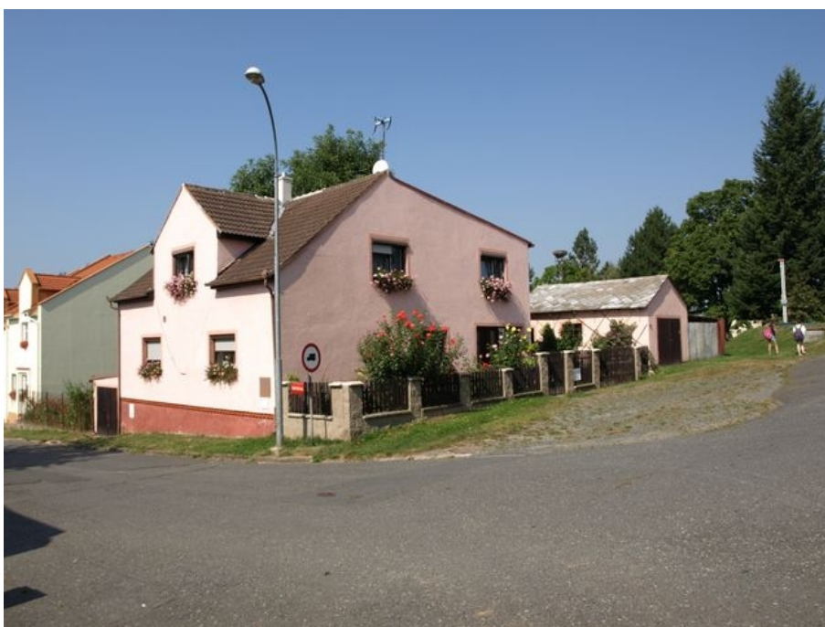
Obrázek 81: Pohled od jihu na dům č.p. 56. Je patrná nepravidelná nástavba severní části domu. 2016. Zdroj: vlastní.
