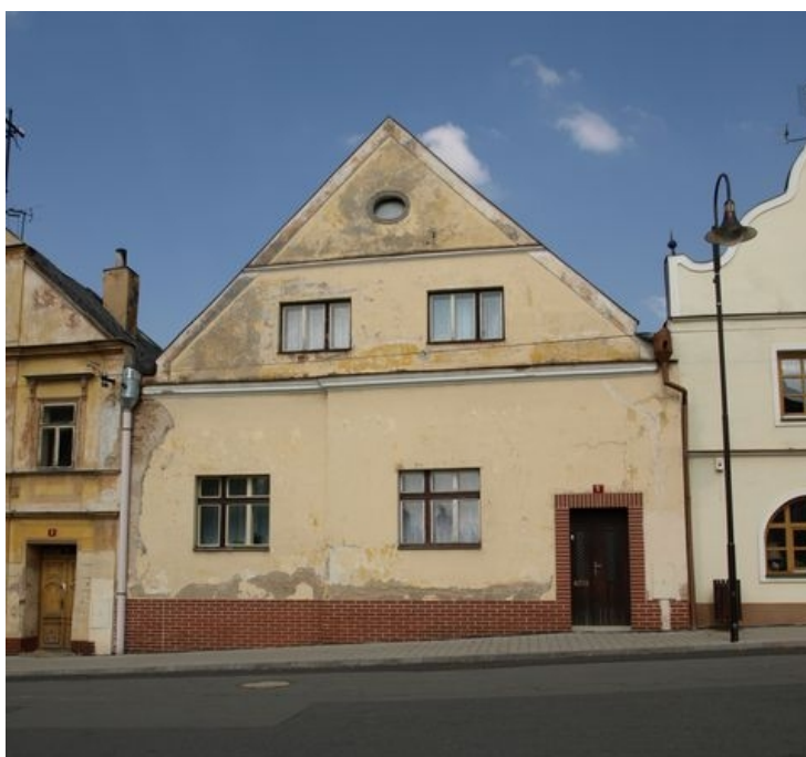
Obrázek 56: Jižní průčelí domu č.p. 5 na náměstí Míru. 2016. Zdroj: vlastní
