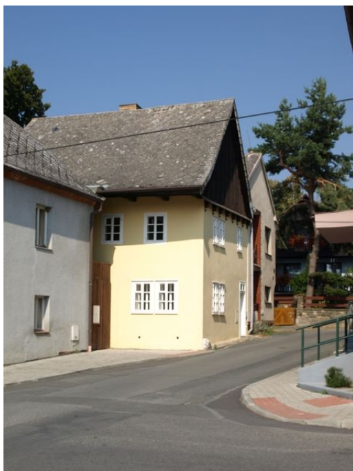
Obrázek 76: Dům č.p. 64 po rekonstrukci. 2016. Zdroj: vlastní
