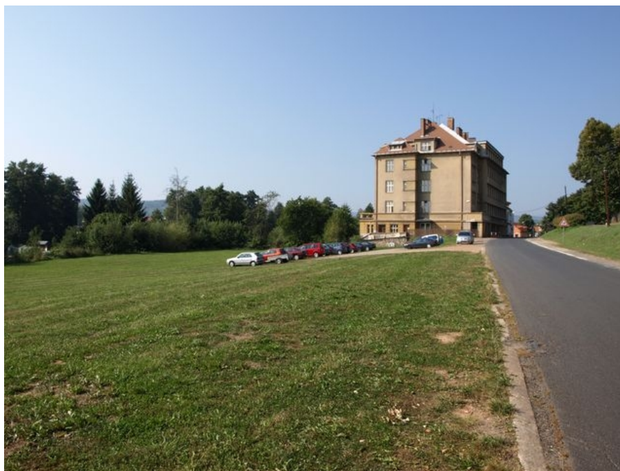
Obrázek 31: Proluka po bývalém panském statku a klášteře na pozemcích parc. č. 74 a 72/1. Pohled od východu. 2016. Zdroj: vlastní.
