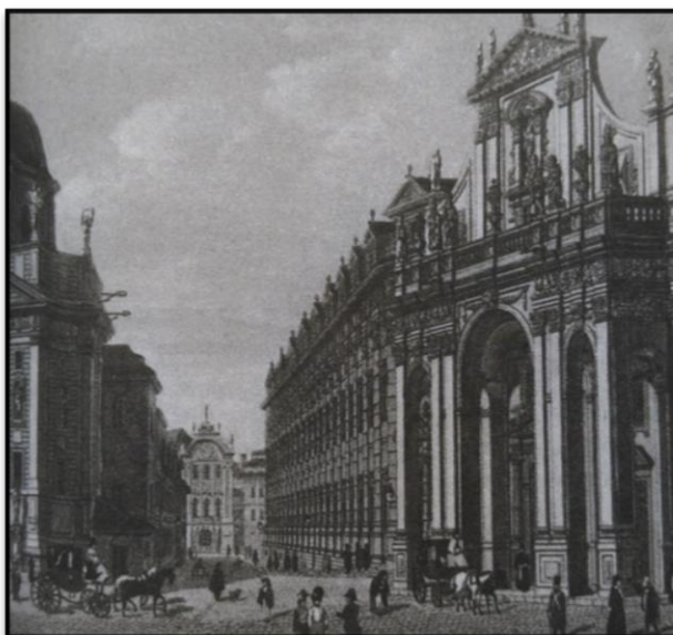
Příloha č. 9: Kostel sv. Salvátora v Praze. 182
