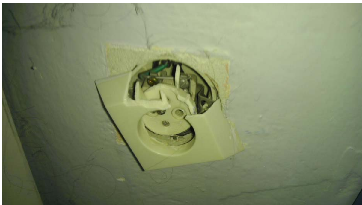
Obr. p3 stav jedné ze zásuvek
