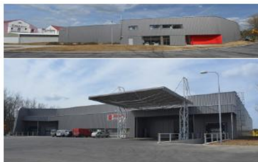
Vysočany – neue Produktionshalle
