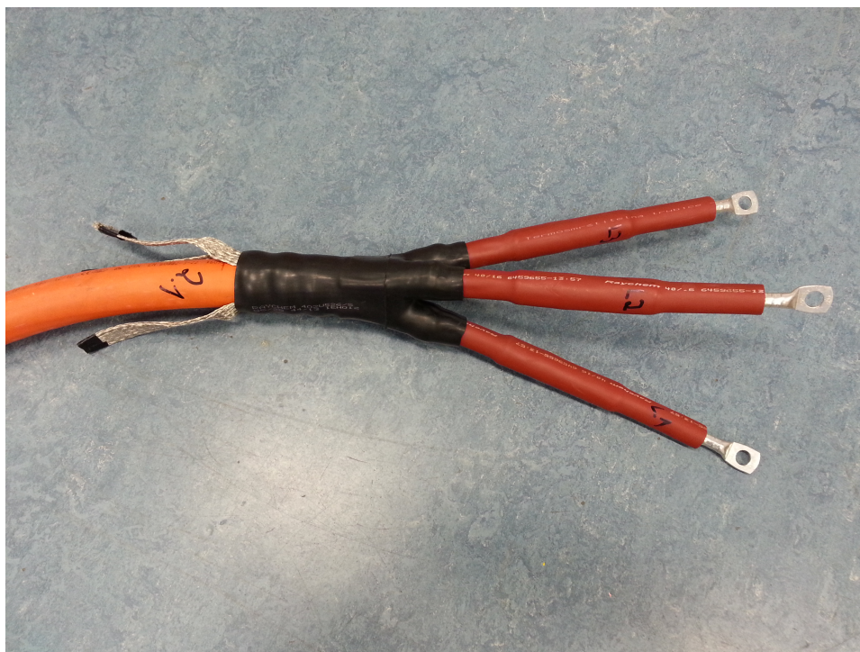
Obrázek 38: Hotové kabelové zakončení (vzorek 2.1)
