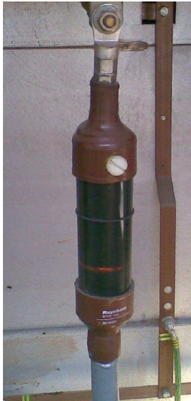
Obrázek 6: Dolévací koncovka (převzato z [20])
