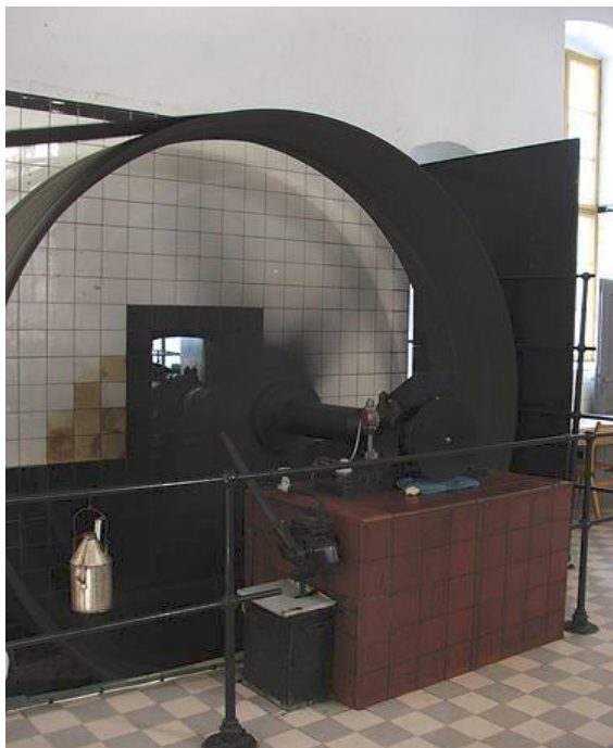
Obr. 1. 1 Pohled do strojovny první vodní elektrárny v Písku (převzato z [5])
