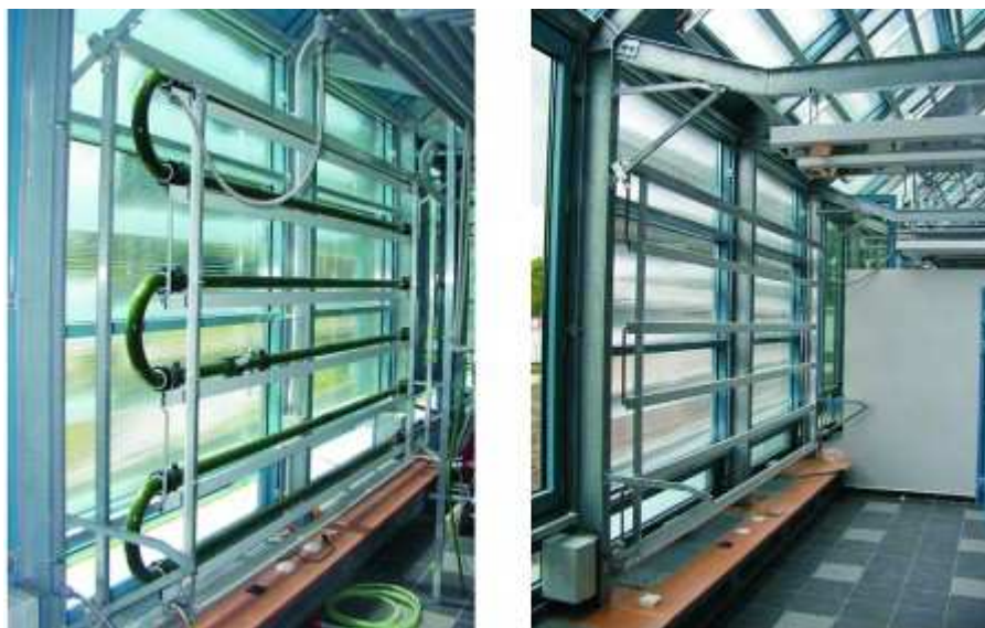
Obrázek 36: Fasádní solární kolektor s lineárními Fresnelovými čočkami [8]
