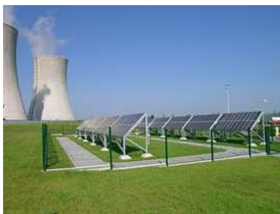
Obrázek 29: FV elektrárna v Dukovanech [9]
