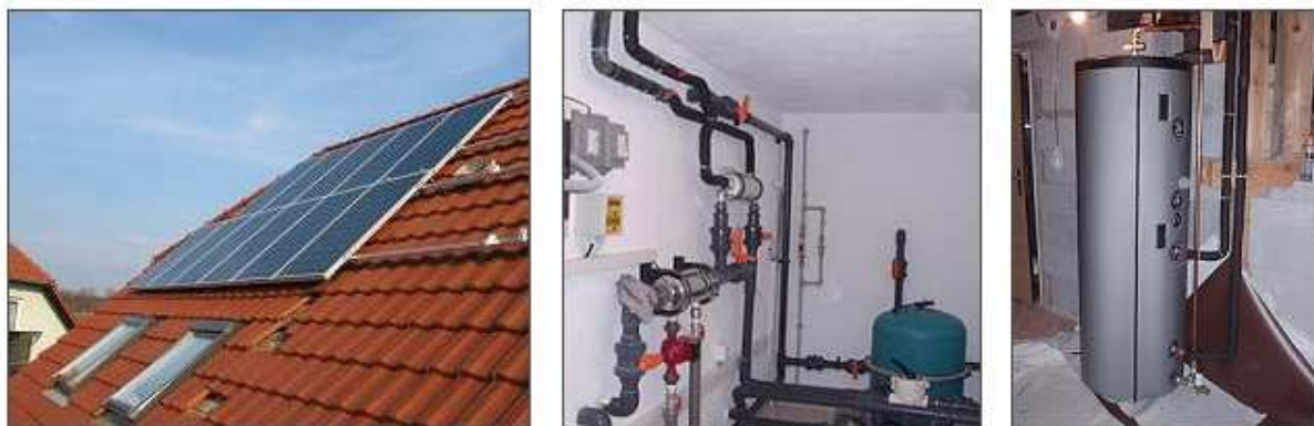
Obrázek 40: Praktická ukázka dvouokruhového solárního systému [9]
