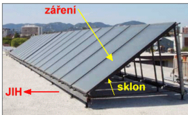
Obrázek 40: Ukázka orientace a sklonu kolektoru [9]
