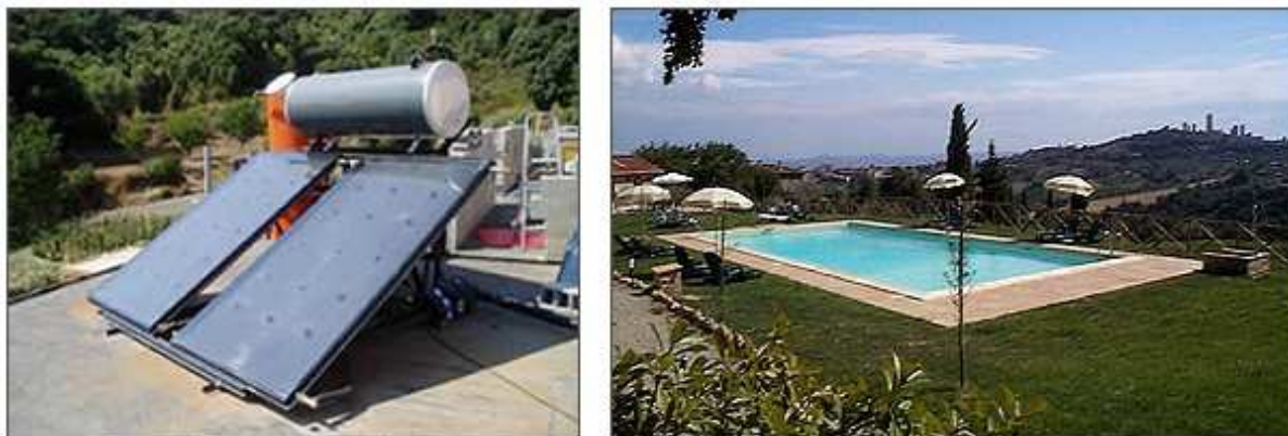
Obrázek 42: Praktická ukázka jednookruhového kapalinového solárního systému [9]
