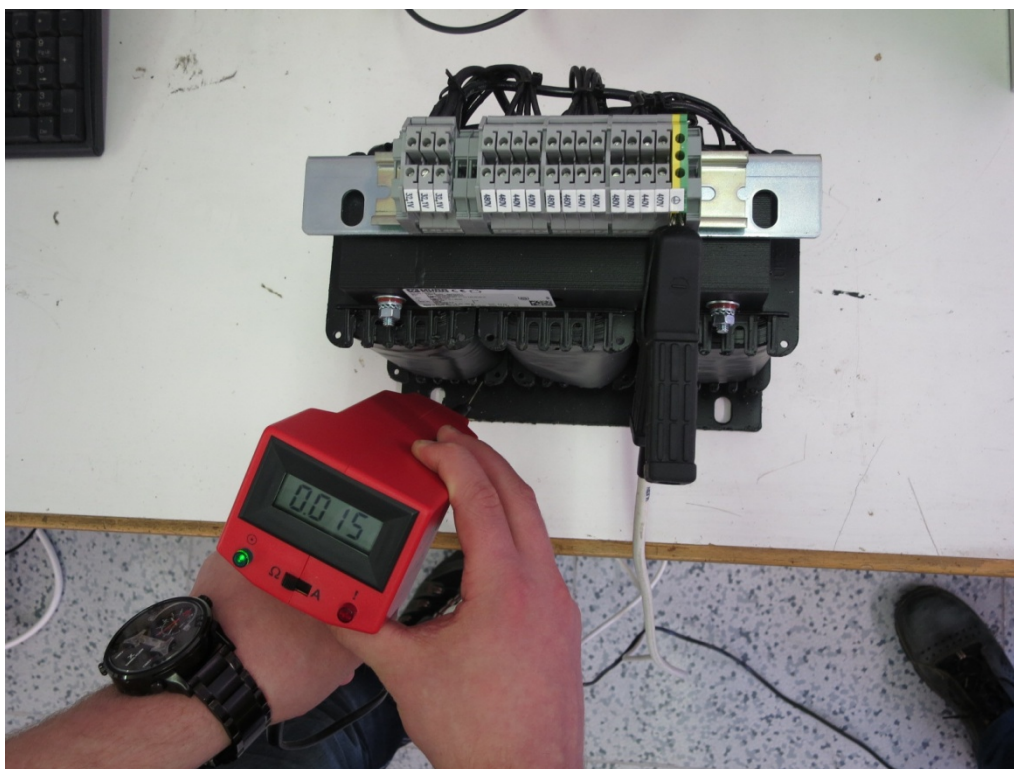
Obr. 2.1 Měření zemnicího odporu
