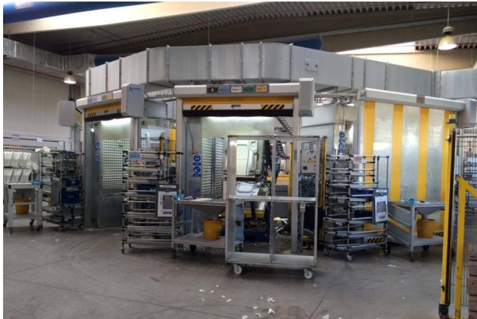
Obr. č. 14: Pohled na kóji č. 8
