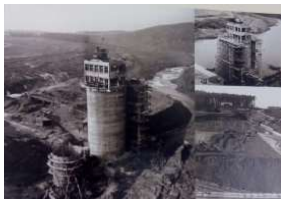
Obr. 2 – Začátek sypání hráze 1961 a stavba elektrárny, výstava Zmizelá Mže 9.7.2016
