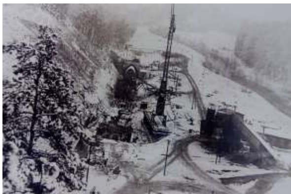
Obr. 1 – Stavba hráze Hracholuské přehrady, celoroční provoz; výstava Zmizelá Mže 9.7.2016
