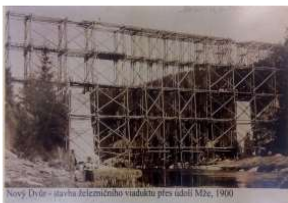
Obr. 5 – Výstavba železničního mostu Nový Dvůr, výstava Zmizelá Mže 9.7.2016
