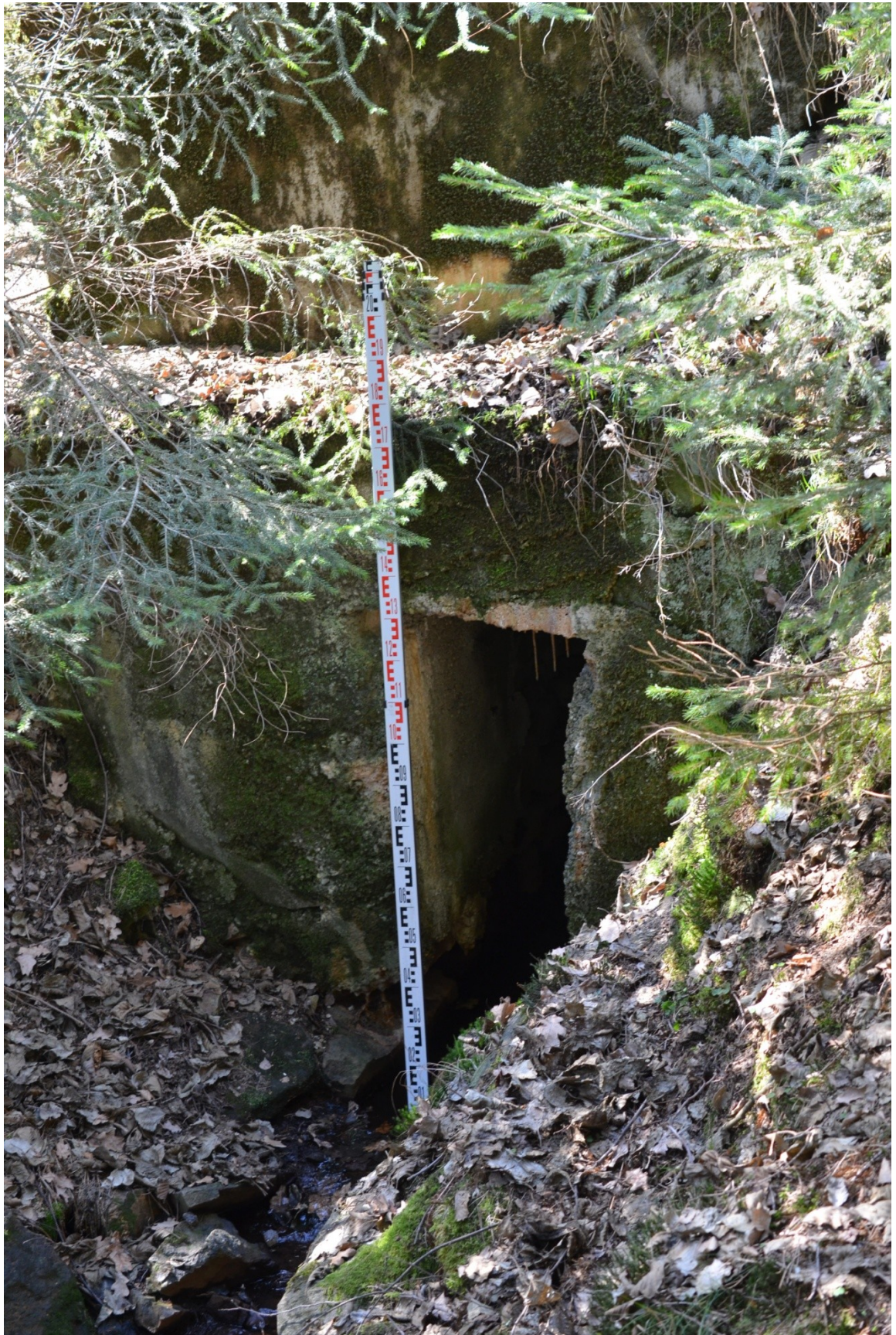
Obr. 22. Rybník č. 2 - novodobá propust' (fotografie Ladislav Čapek)
