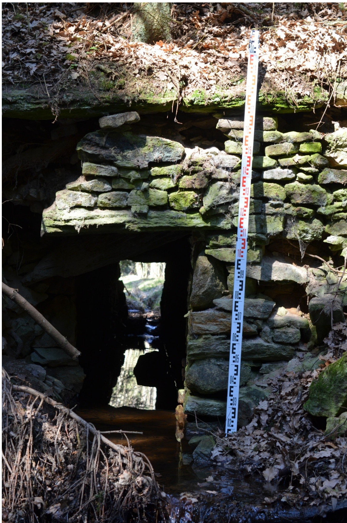
Obr. 13. Malý prochodský rybník, kamenná propust' (fotografie Ladislav Čapek)
