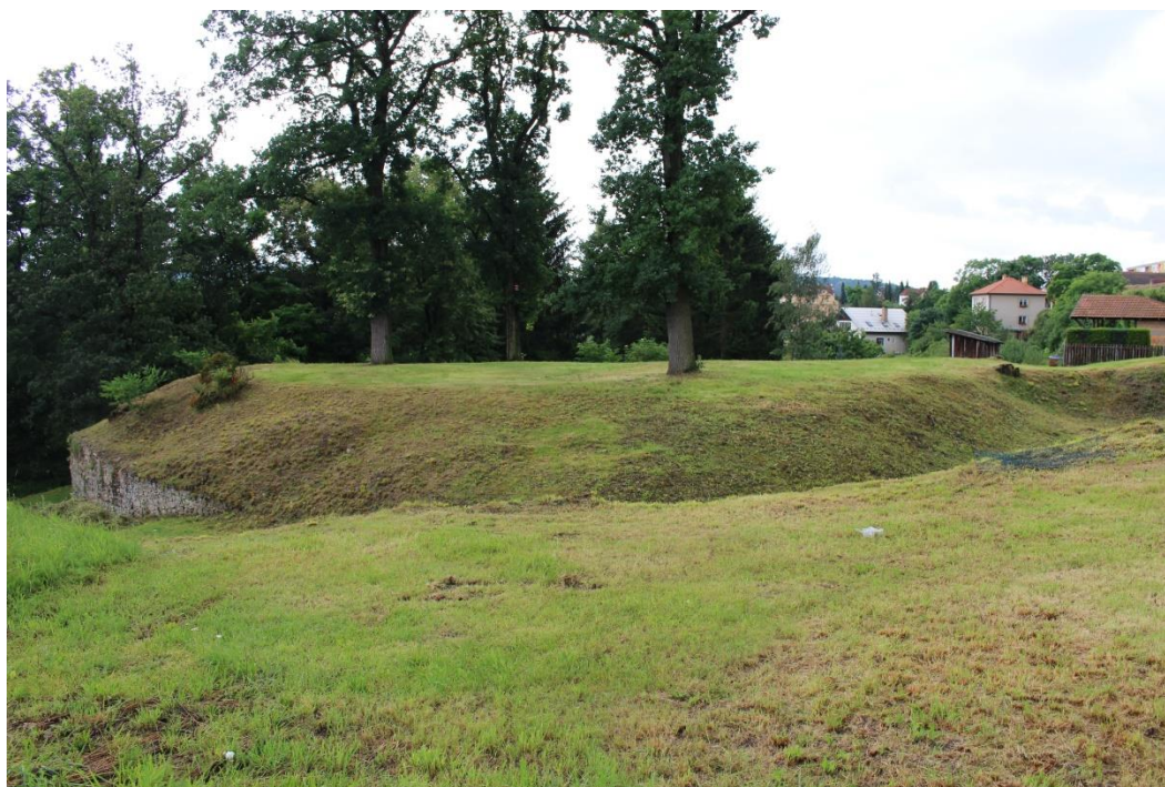
Obr. č. 15 Nezvěstice (okr. Plzeň-jih) současný stav tvrziště – východní strana. Foto autorka 2016.
