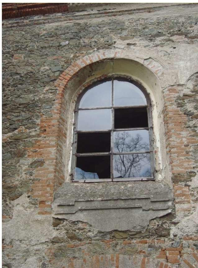
Obr. 80 Kostel sv. Barbory – okno s pozůstatky výplně v severní zdi (foto autorka, 2016).
