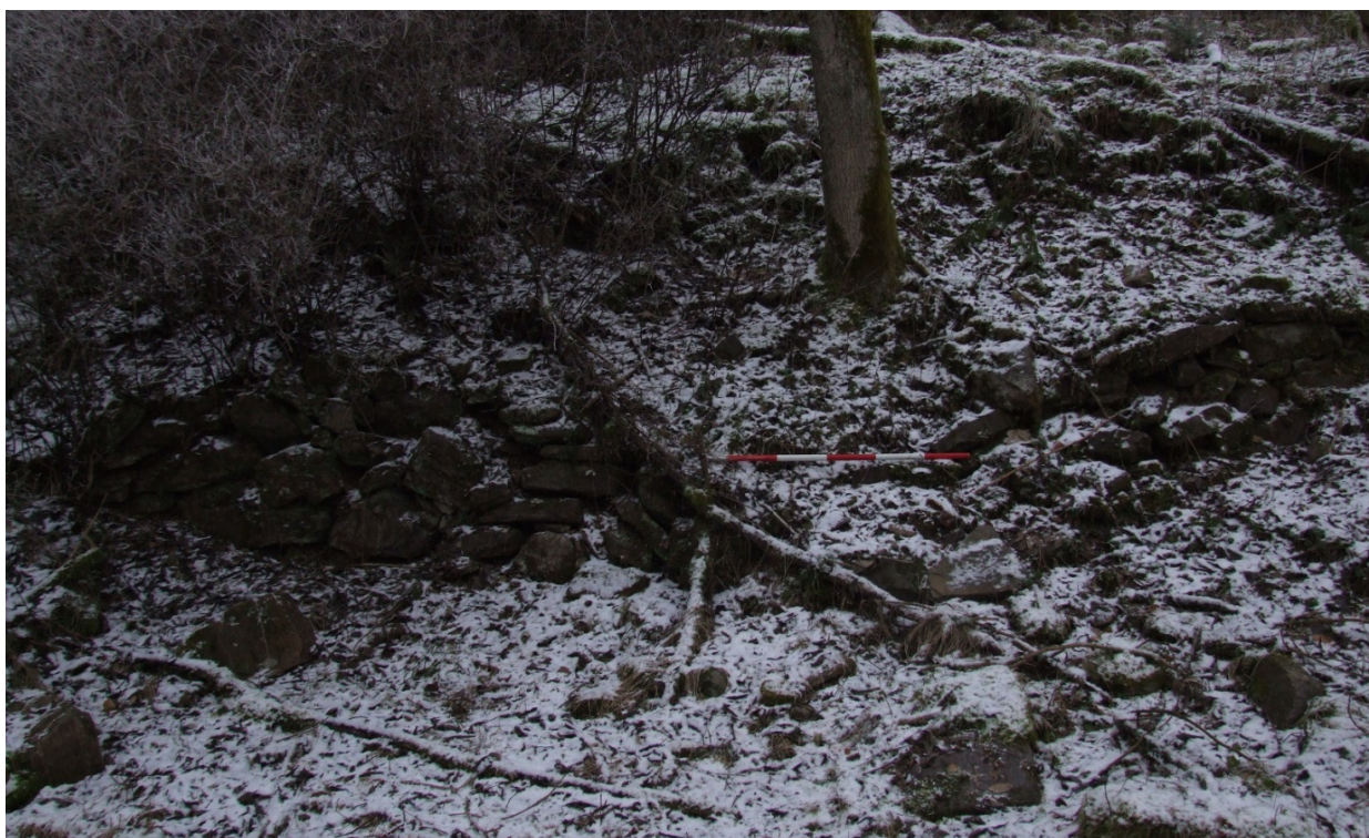
Obr. 40 Lokalita Kaplička, taras z nasucho poskládaných kamenů, nacházející se pod terénní hranou (foto autorka, 2016).
