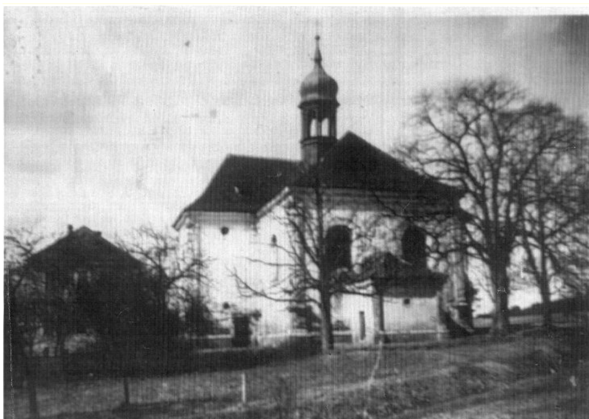
Obr. 67 Kostel sv. Barbory i s budovou německé školy, datace neznámá (obec Všekary 2017 [online]).
