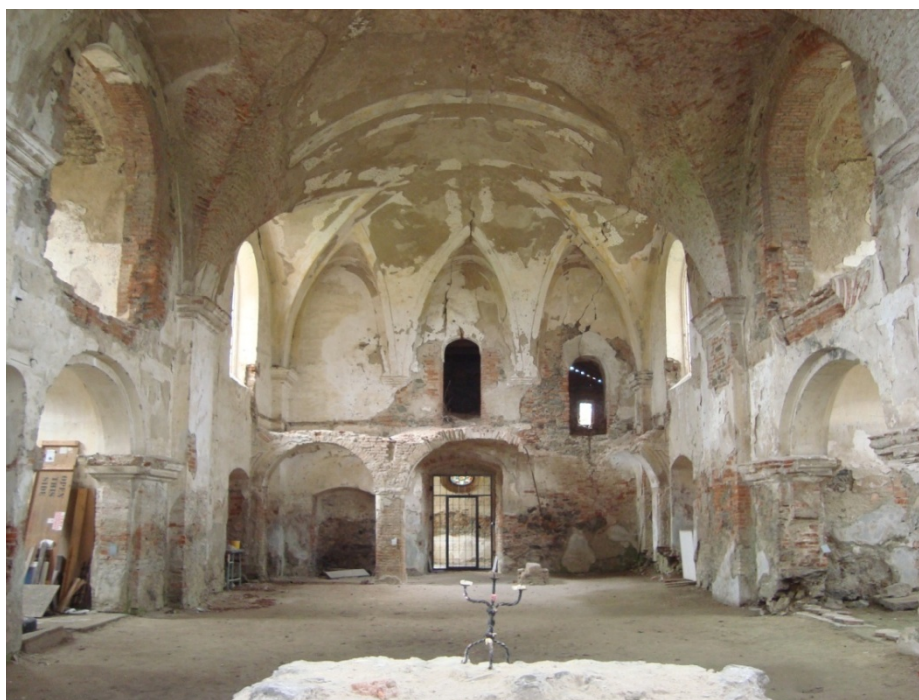
Obr. 82 Kostel sv. Barbory – pohled na kruchtu (foto autorka, 2016).
