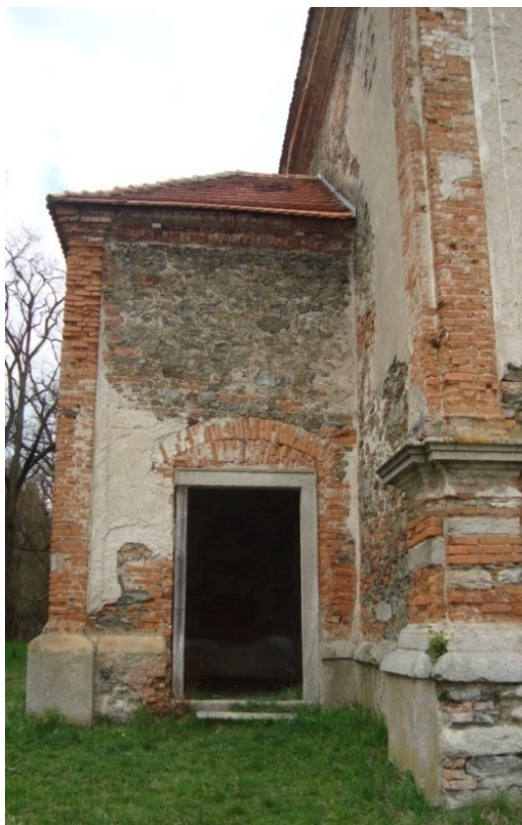
Obr. 75 Kostel sv. Barbory - předsíň připojená k východní straně s hlavním vstupem (foto autorka, 2016).
