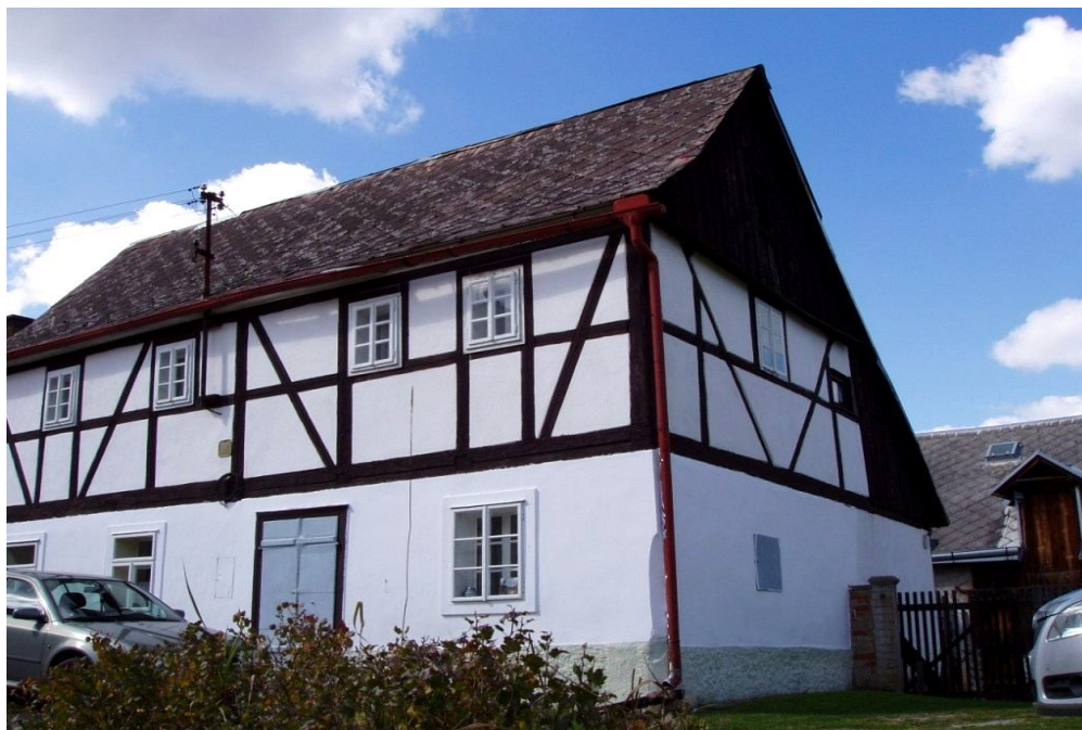
Obrázek č. 33: Dům čp. 62, foto Jana Korolová, 2010.
