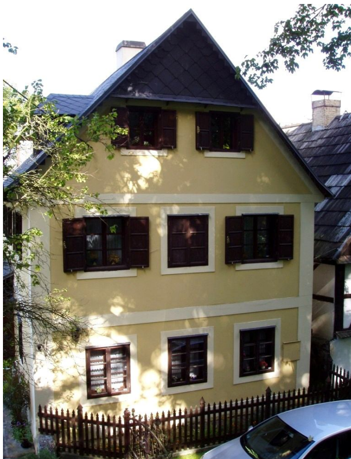
Obrázek č. 37: Dům čp. 84, foto Jana Korolová, 2010.
