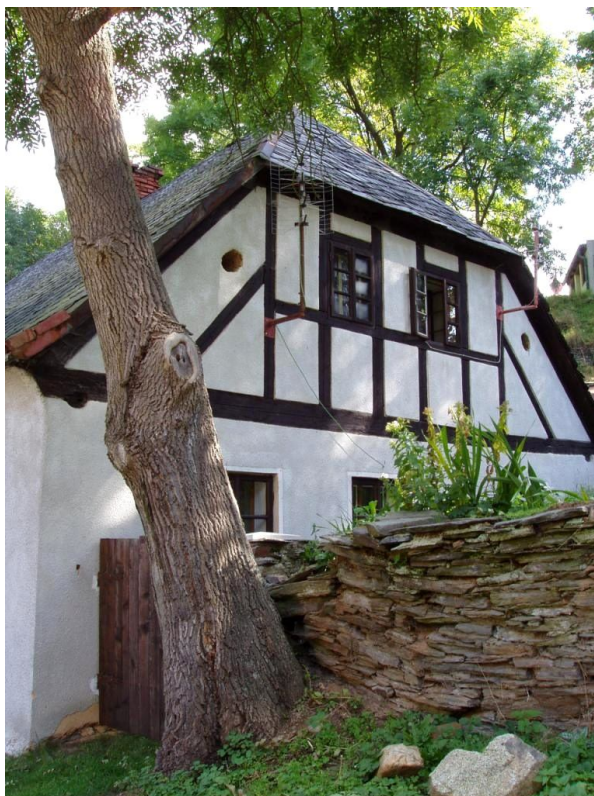
Obrázek č. 35: Dům čp. 82, foto Jana Korolová, 2010.
