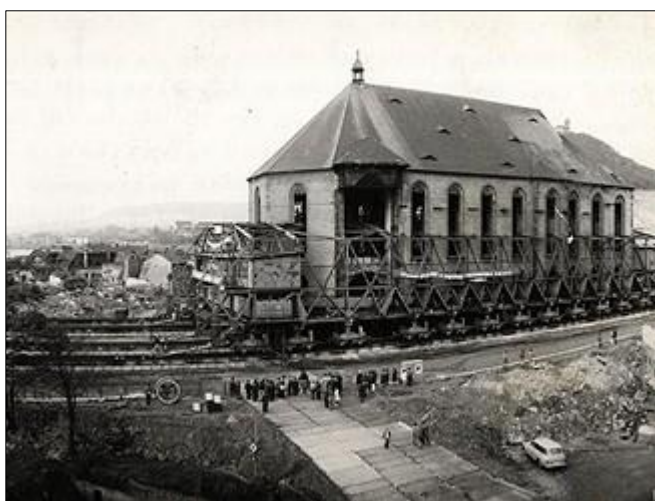
Obrázek 4 Přesouvání kostela na kolejnicích
