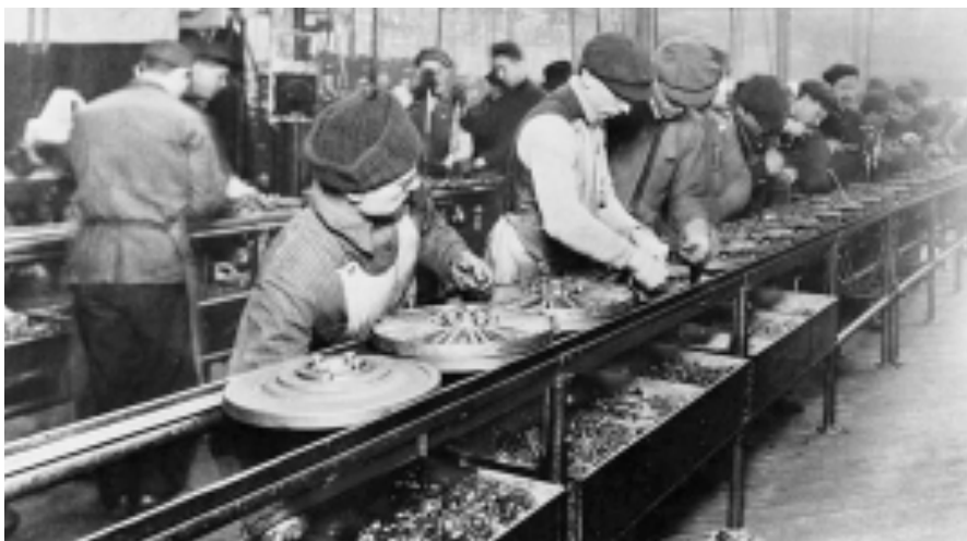
Obrázek 1-2 Jedna z prvních montážních linek v továrně Henryho Forda [1]
