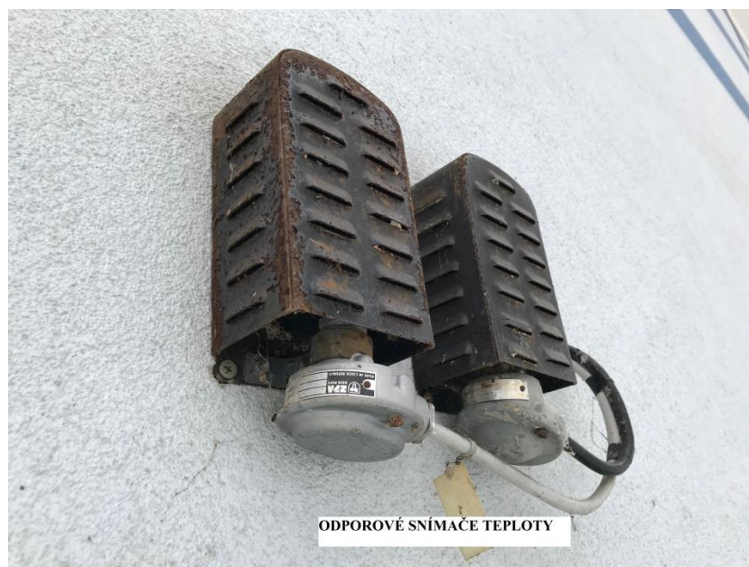
Obrázek 8.5: Odporové teploměry v ochranném krytu. Zdroj vlastní
