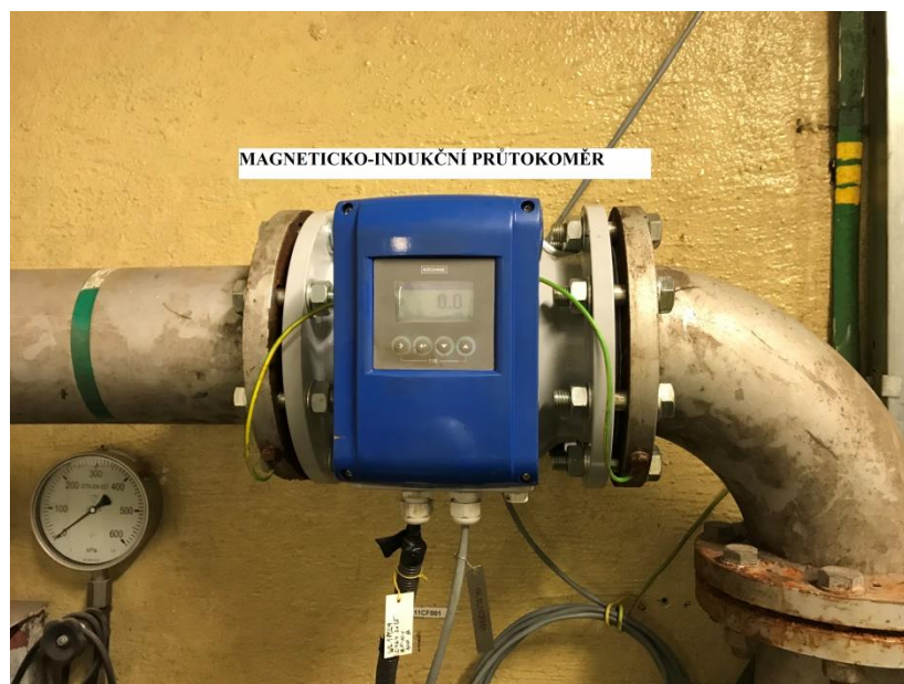
Obrázek8.7: Magneticko-indukční průtokoměr- horizontální připojení. Zdroj vlastní
