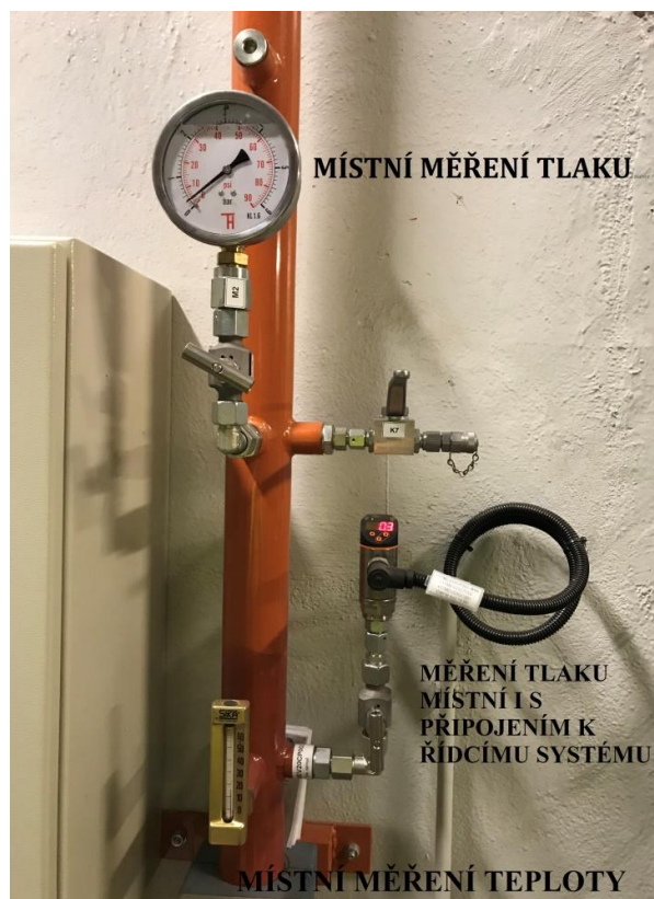
Obrázek 8.1: Technologie s manometrem, snímačem tlaku, teploměrem. Zdroj vlastní
