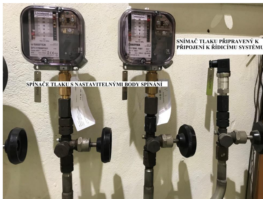
Obrázek 8.4: Tlakové spínače a snímač tlaku. Zdroj vlastní
