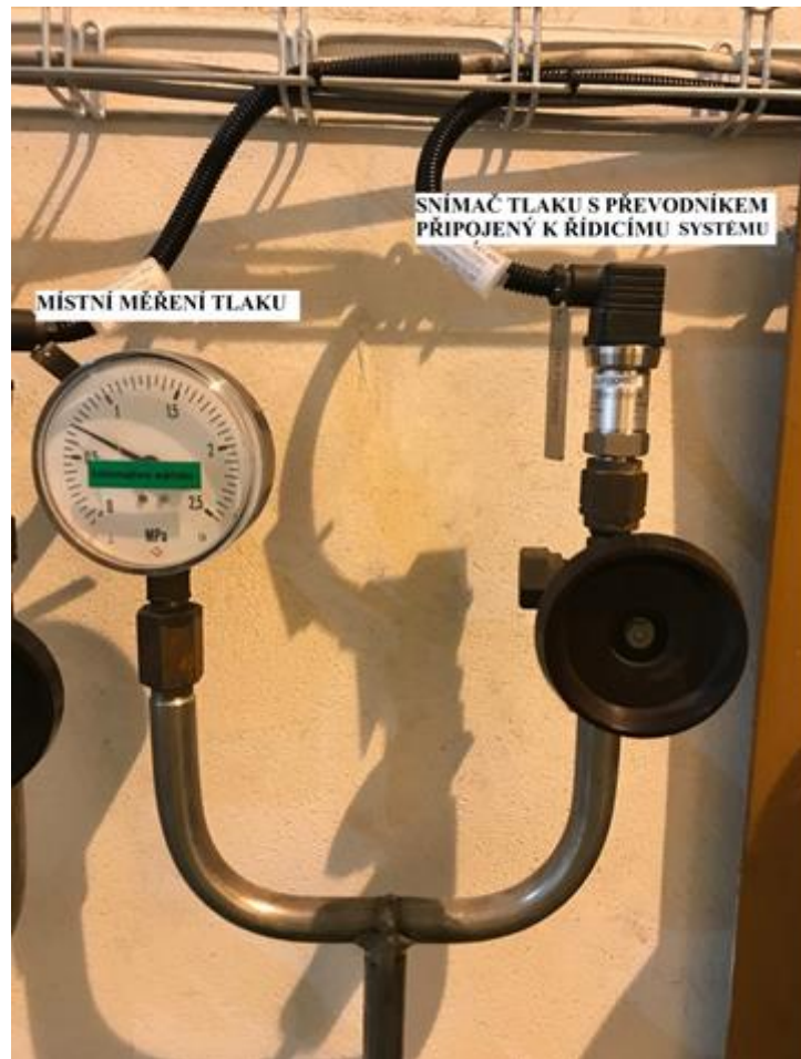
Obrázek 8.3: Měření tlaku- manometr (místní měření) a snímač tlaku. Zdroj vlastní
