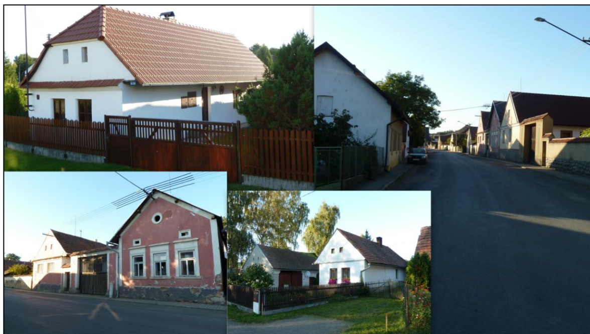
Příloha č. 2 – Venkovská stavení v sídlech Obce Řeňče
