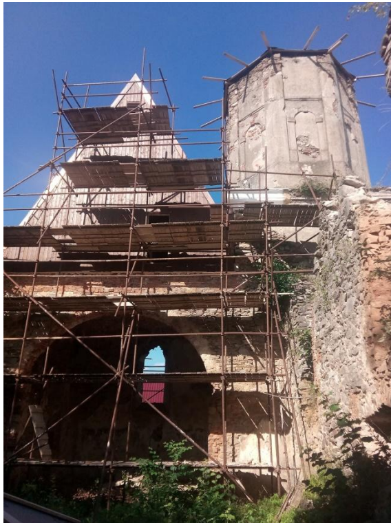
Foto 5: Der gegenwärtige Zustand des Kirchengebäudes. Die Renovierungsarbeiten (1).
