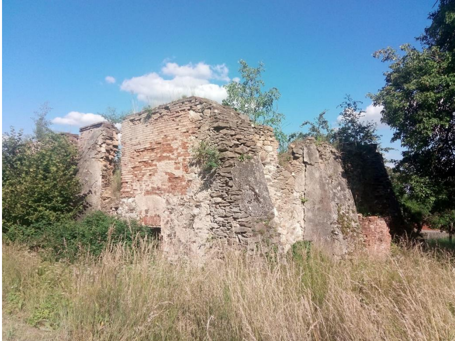
Foto 9: Der gegenwärtige Zustand des ehemaligen Pfarrhauses (2).
