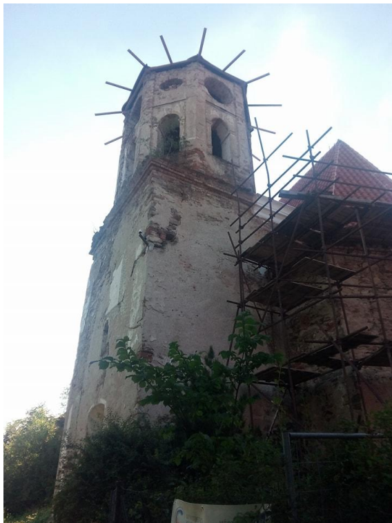
Foto 6: Der gegenwärtige Zustand des Kirchengebäudes. Die Renovierungsarbeiten (2)
