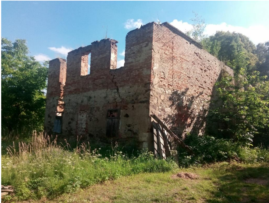
Foto 10: Der gegenwärtige Zustand des ehemaligen Pfarrhauses (1).
