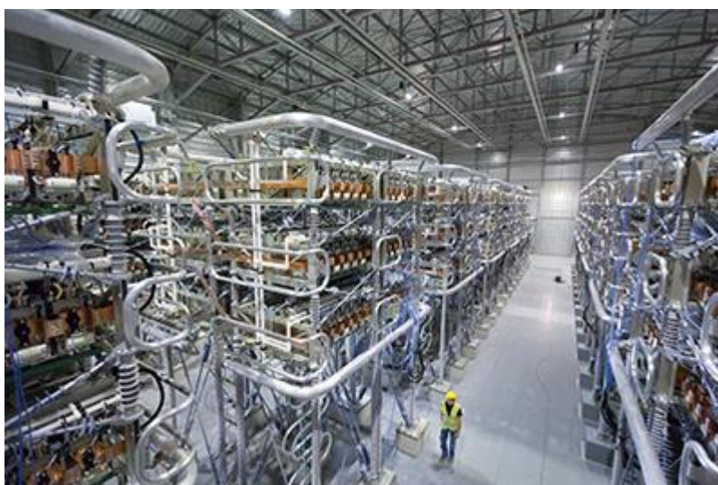
Obrázek 46 - HVDC střídač [17]
