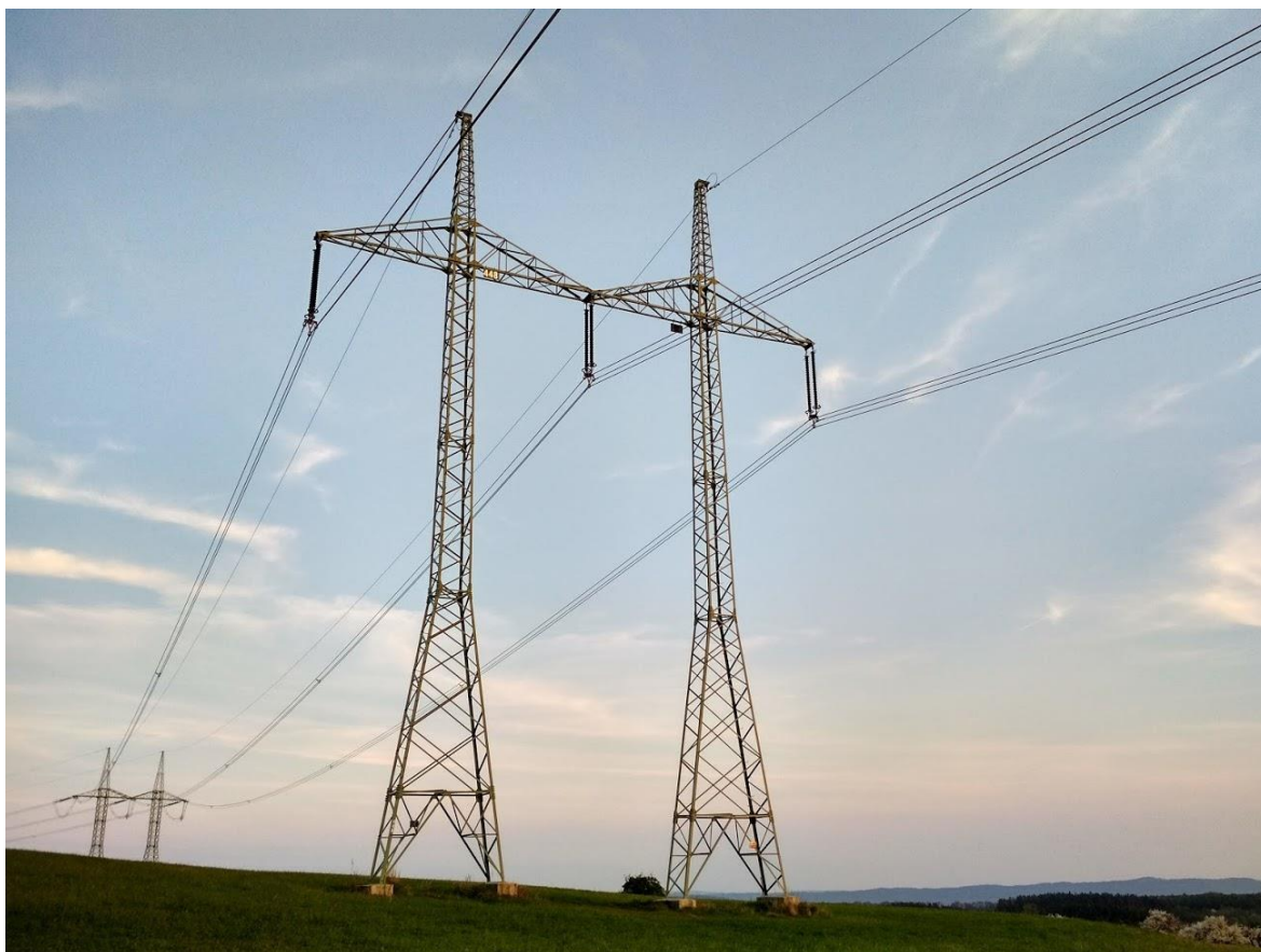
Obrázek 47 - Portálový stožár
