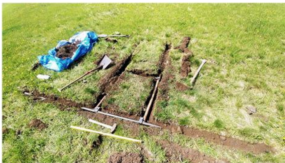
příloha č. 10 ukotvení, vlastní fotografie
