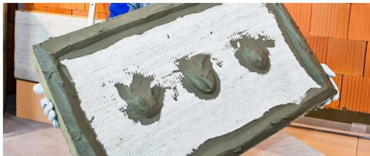
Obrázek 4 - Příklad nanesení tmelu na izolační desku
