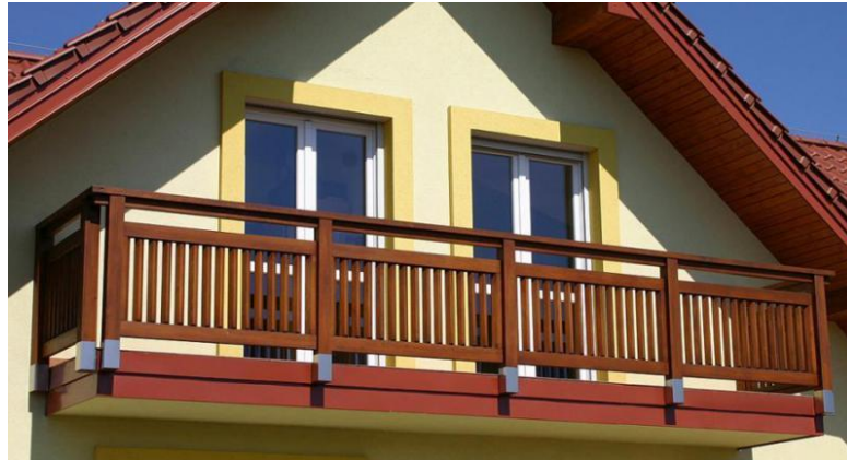
Obr. 10 – kombinovaný balkón (železobeton, dřevo) [13]
