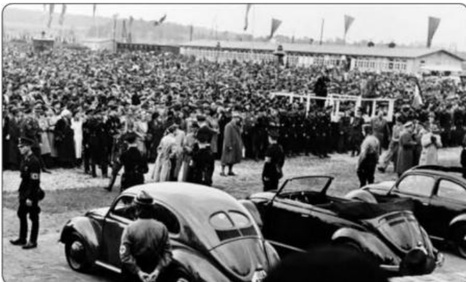
Příloha č. 2 – Vystavené lidové vozy při slavnostním položení základního kamene automobilové továrny.
