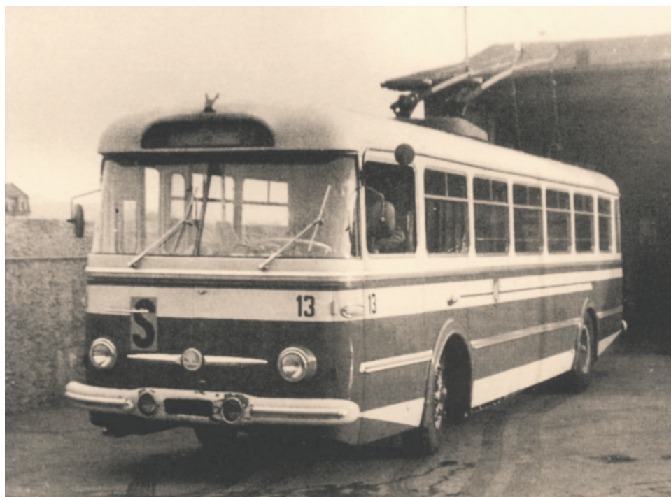
Obr.29: Prototyp 9TrP s hydropneumatickým vypružením ve službách DP Děčín. [30]
