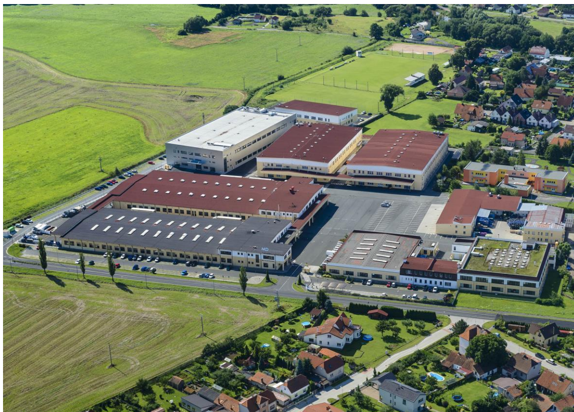
Obr. č. 8 Areál závodu v Chotěšově
