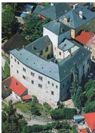
Obr. 66 Hrádek v Kutné Hoře – letecký pohled
