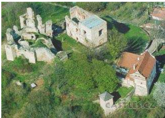
Obr 85 Košumberk – letecký pohled (v levé horní čtvrtině jádro hradu)
