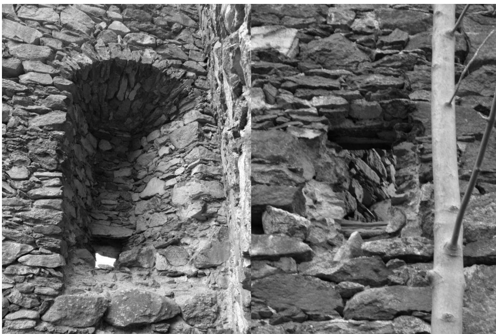
Obr. 21, 22: zazděná střílna v severozápadním nároží východního paláce. Pohled z interiéru a exteriéru. Foto autor
