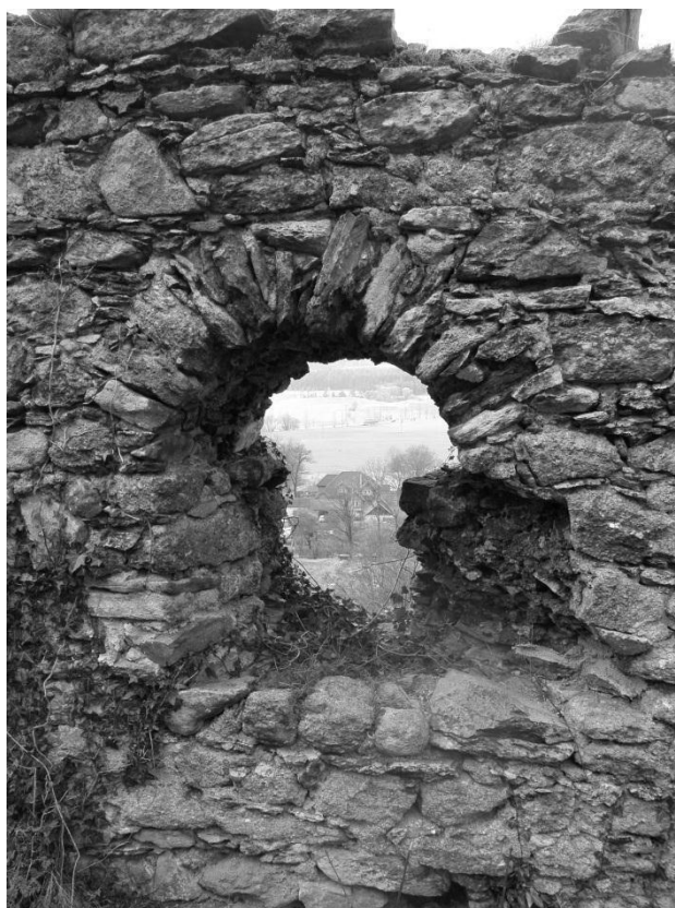
Obr 18: střílna s oboustranně se otevírajícími špaletami. Foto autor
