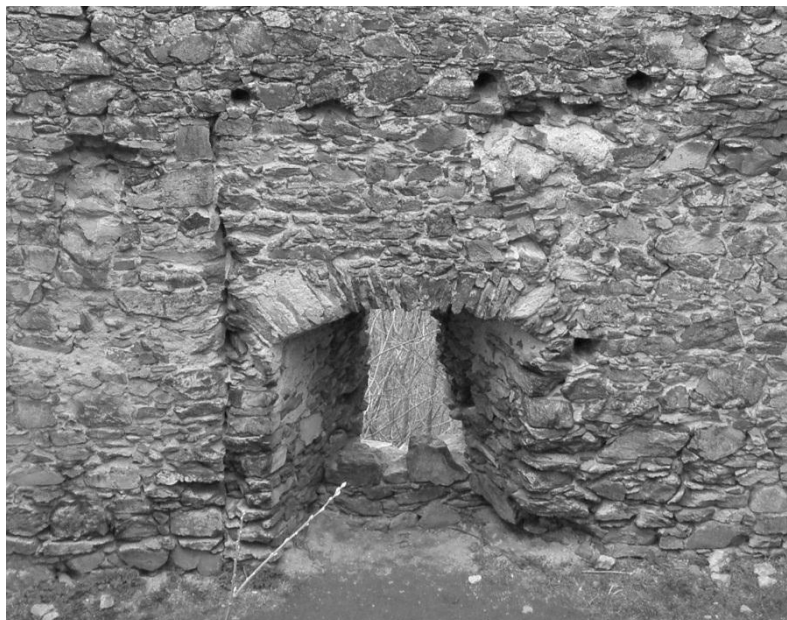
Obr. 20: střílna v přízemí druhé brány. Při levé straně patrná spára ve zdivu Foto autor
