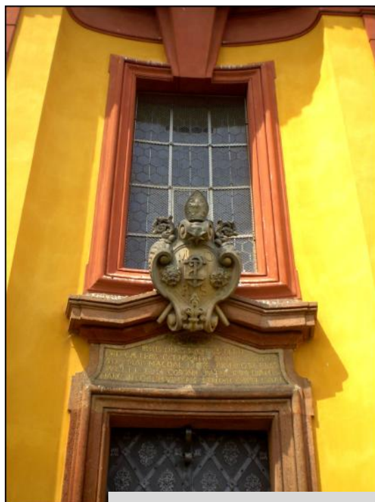
Popis: Detail průčelí s profilovanou zdi s bosovaným nárožím Zdroj: Vlastní foto
