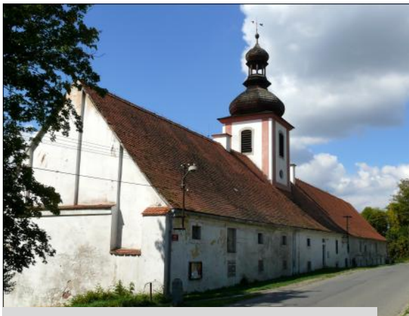
Popis: Plasy hospodářský dvůr. Stáje se zvonící. Severovýchodní pohled.
