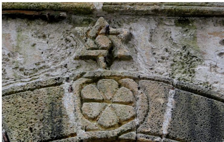
Obr. 3. Průčelí domu se židovskou hvězdou v Essawíře (Foto: Katarína Maruškinová, duben 2014)
