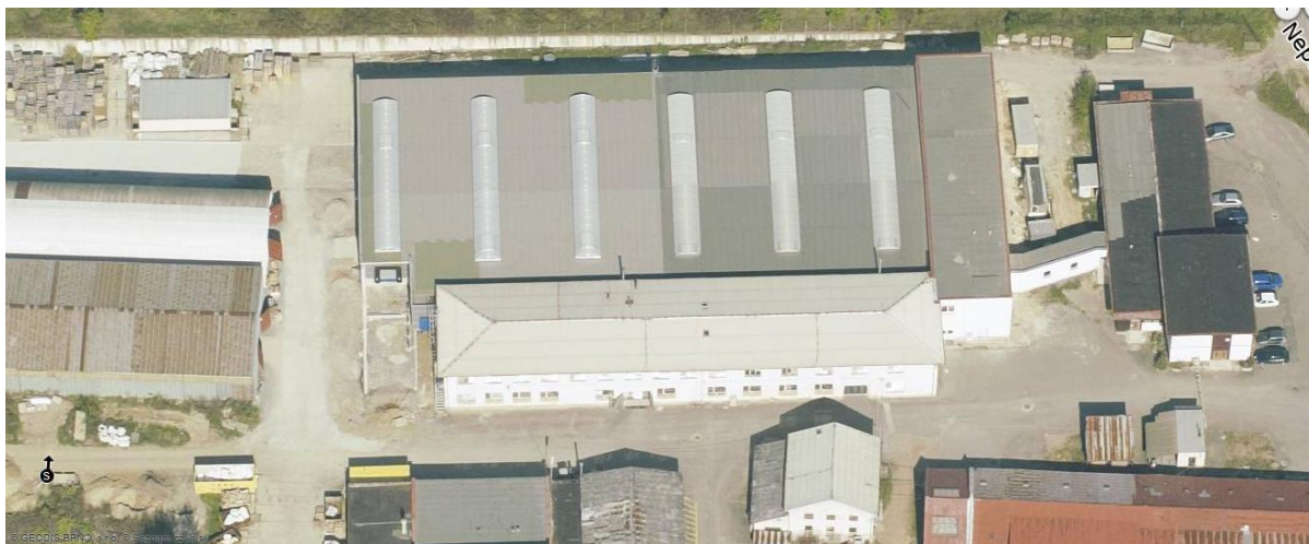
Obr. č. 5: Pohled na novou výrobní halu, v popředí administrativní hala
