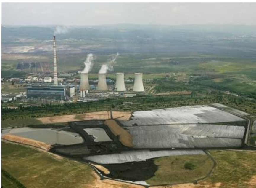
Obr. č. 15: Elektrárna Tušimice
