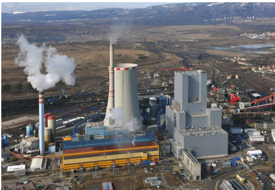
Obr. č. 16: Elektrárna Ledvice
