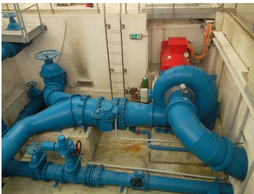
Obrázek 3.2 Soustrojí s Francisovou turbínou na MVE Želivka
