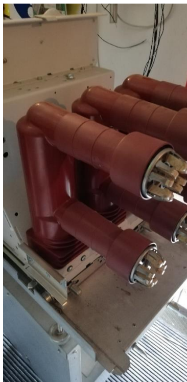
Obrázek 4.3 Póly vakuového vypínače
