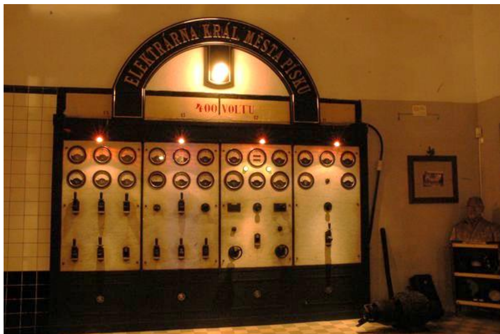
Obrázek 1.1 Vodní elektrárna královského města Písku
