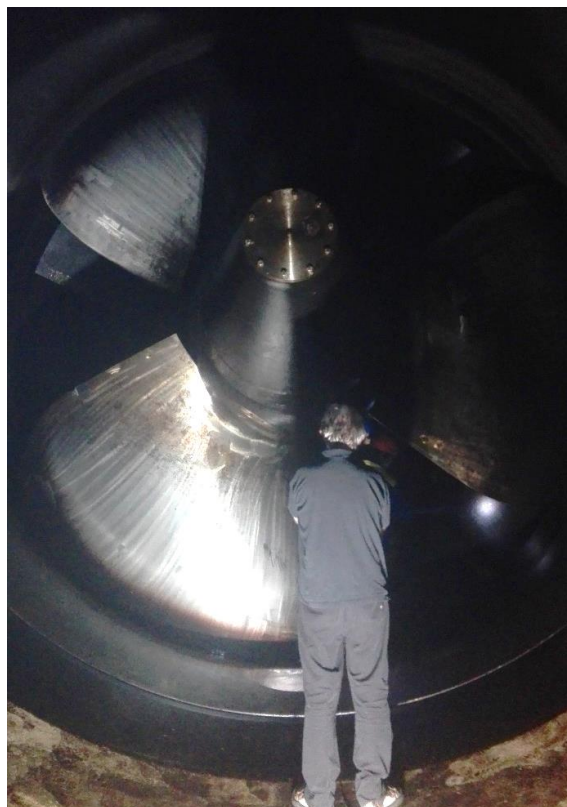
Obrázek 3.3 Kaplanova turbína (MVE Štětí)
