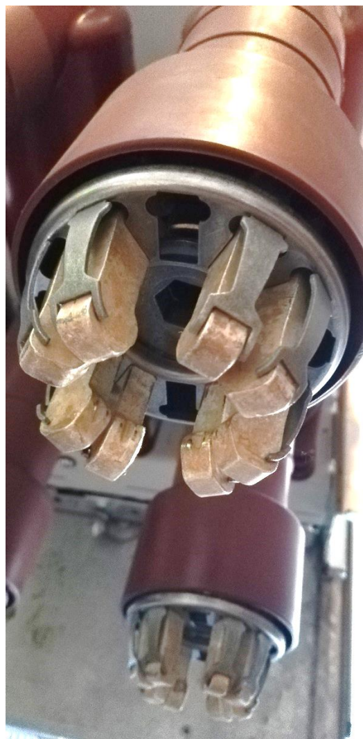
Obrázek 4.5 Detail odpojovacích kontaktů
