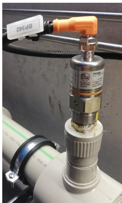
Obrázek 4.9 Snímače tlaku s konektorem
