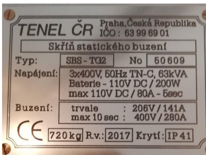
Obrázek 5.8 Štítek skříně statického buzení pro TG na MVE Štvanice
