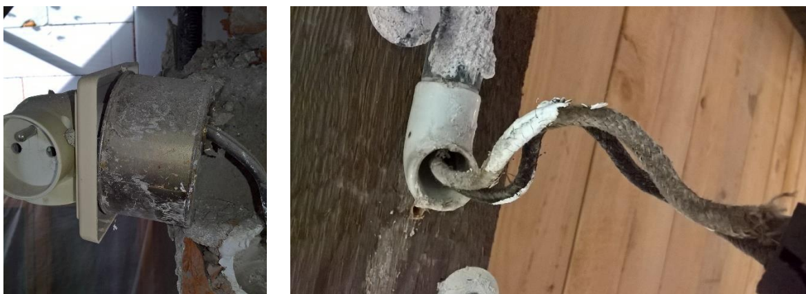
Obr. 1.1 součásti elektroinstalace realizované v 50. letech min. století
