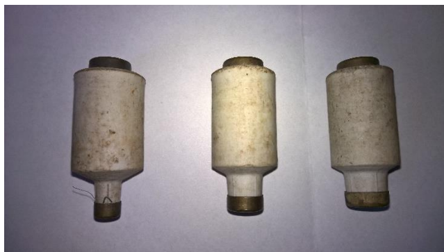
Obr. 1.2 Pojistky používané v domovních elektroinstalacích
