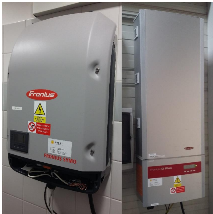
Obr. 2.6 Střídače Fronius Symo 3.0 (vlevo) a IG Plus 80-3 (vpravo) v Daikinu
