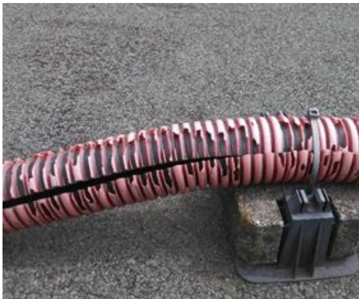
Obr. 2.10 Izolace stejnosměrného vedení
