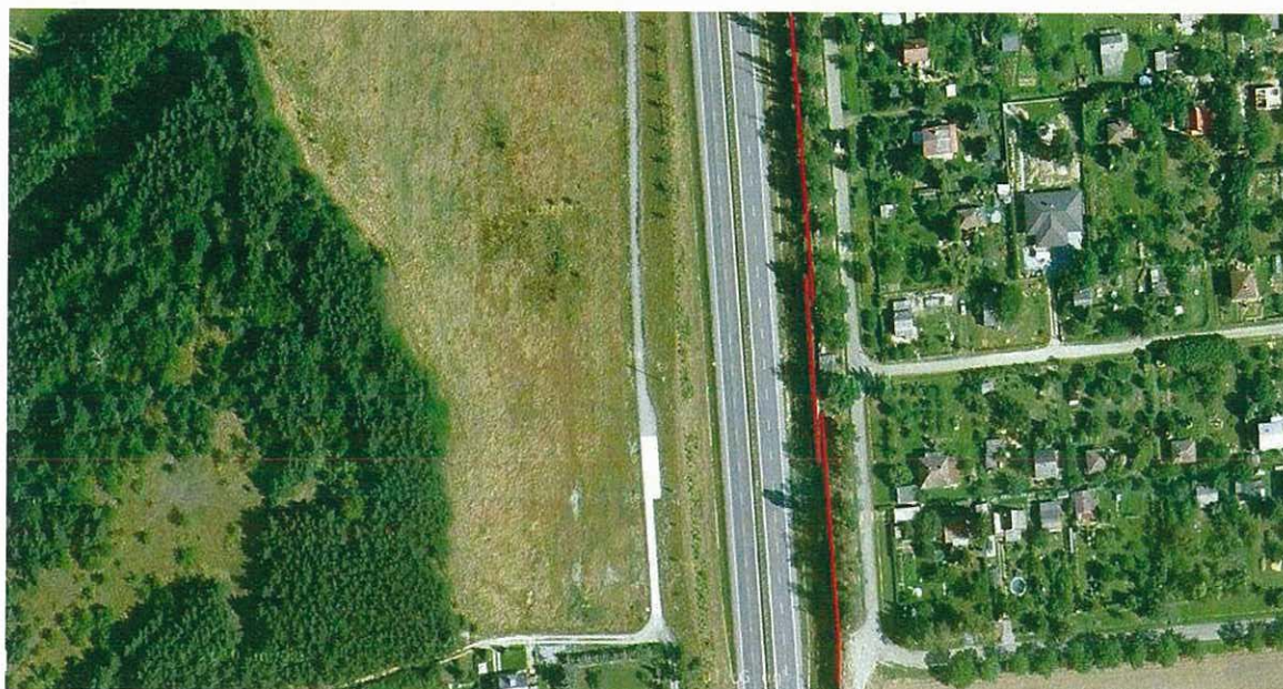
Obr. č. 1. Protihluková stěna
