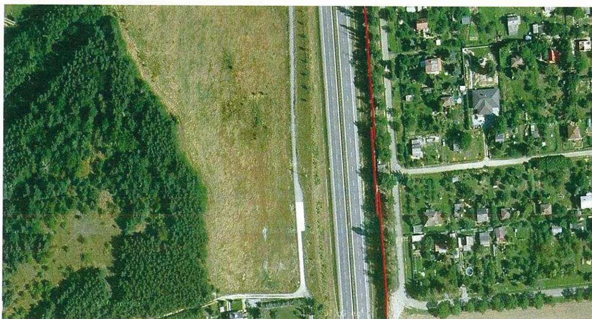
Obr. č. 1. Protihluková stěna
