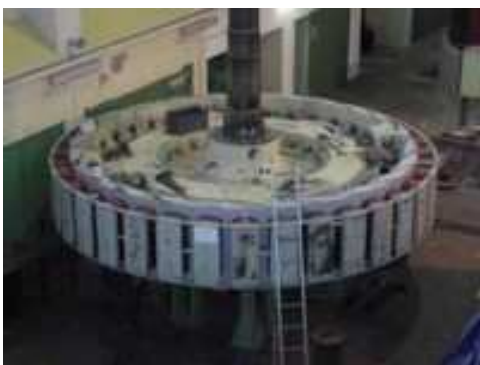
Obr. 3 Rotor hydroalternátoru [20]
