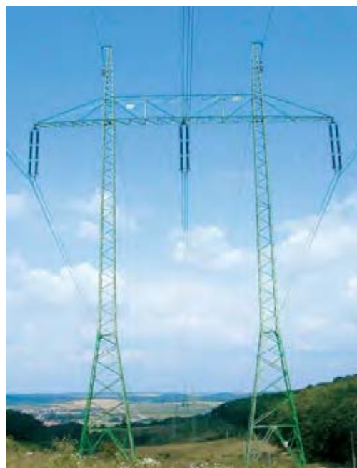
Portál – nosný (1x400 kV) (závěsy DN-keramika, 2xZL)
