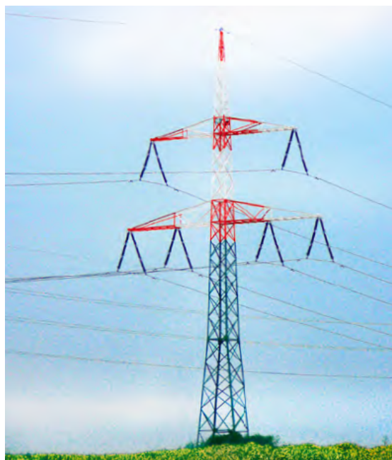
Donau – nosný (2x220 kV) (závěsy PK A -keram., 1xZL, letecké znač.)
