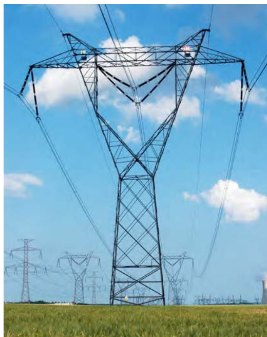
Kočka – nosný (1x400 kV) (krajní závěsy PK A , střední DNV 4 -ker, 2xZL)
