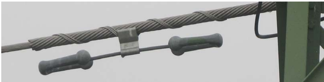
Obr. 1.6 – Tlumič vibrací na ZL – V452. (foto archiv ČEPS, a.s.)
