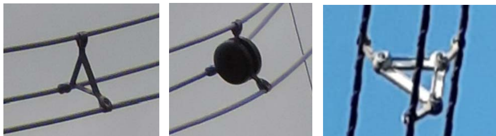
Obr. 1.8 – Distanční trojrozpěrka klasická, se závažím a s tlumením vibrací – 400kV 44
