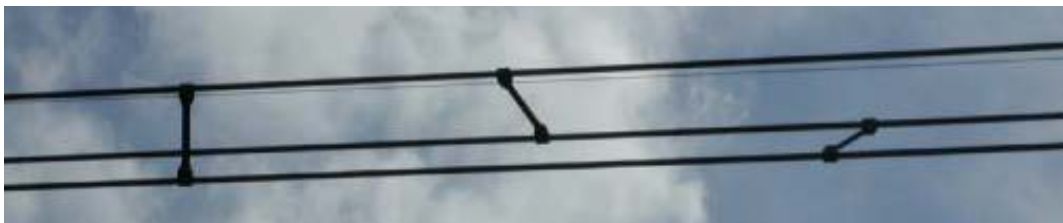
Obr. 1.7 – Distanční dvojrozpěrky na FV – 400kV. (foto archiv ČEPS, a.s.)
