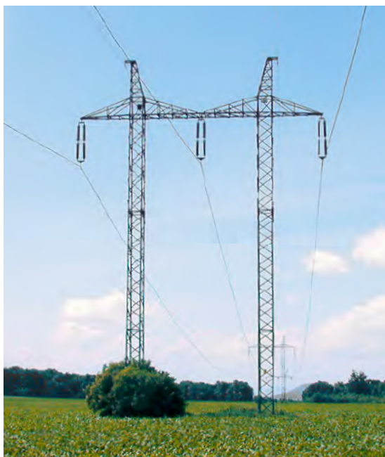
Portál – nosný (1x220 kV) (závěsy DN-keramika, 2xZL)
