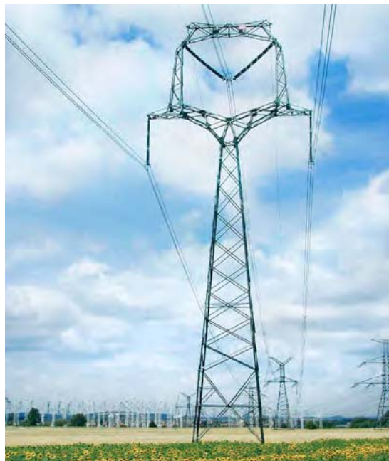
Mačka – nosný (1x400 kV) (krajní závěsy DN, střední DNV 4 -ker., 2xZL)
