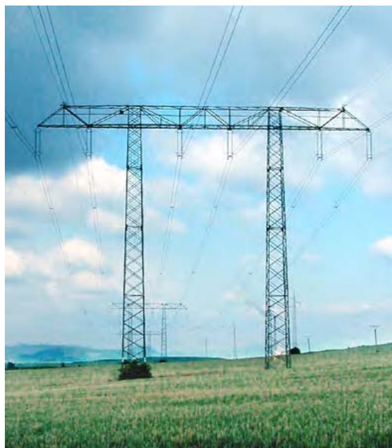
Portál dvojnásobný – nosný (2x220 kV) (FV dvojsvazek, závěsy DN-kompozit, 2xZL)
