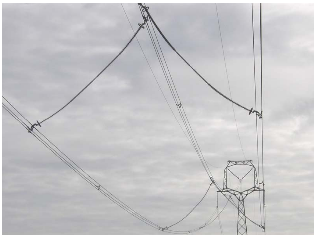
Obr. 1.9 – Příklad instalace rozpěrek ELBA na V459 (foto archiv ČEPS, a.s.)
