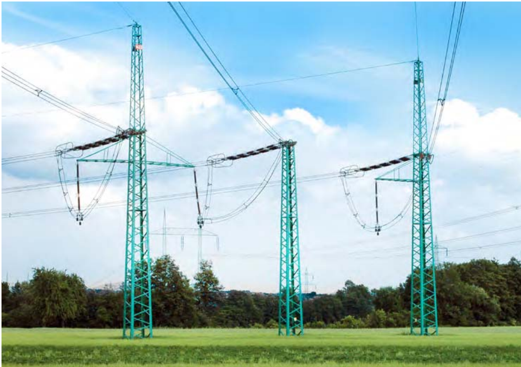
Třídřík – kotevní (1x400 kV) (závěsy TK a PN se závažím v přeponce - keramika, 2xZL)
