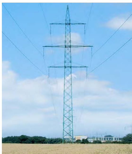
Soudek – nosný (2x220 kV) (závěsy JN-keramika, 1xZL)
