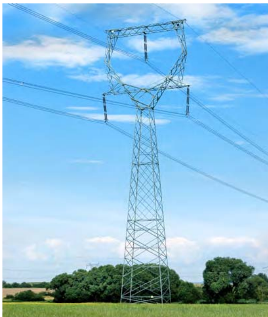
Delta – nosný (1x400 kV) (závěsy DN-keramika, 2xZL)
