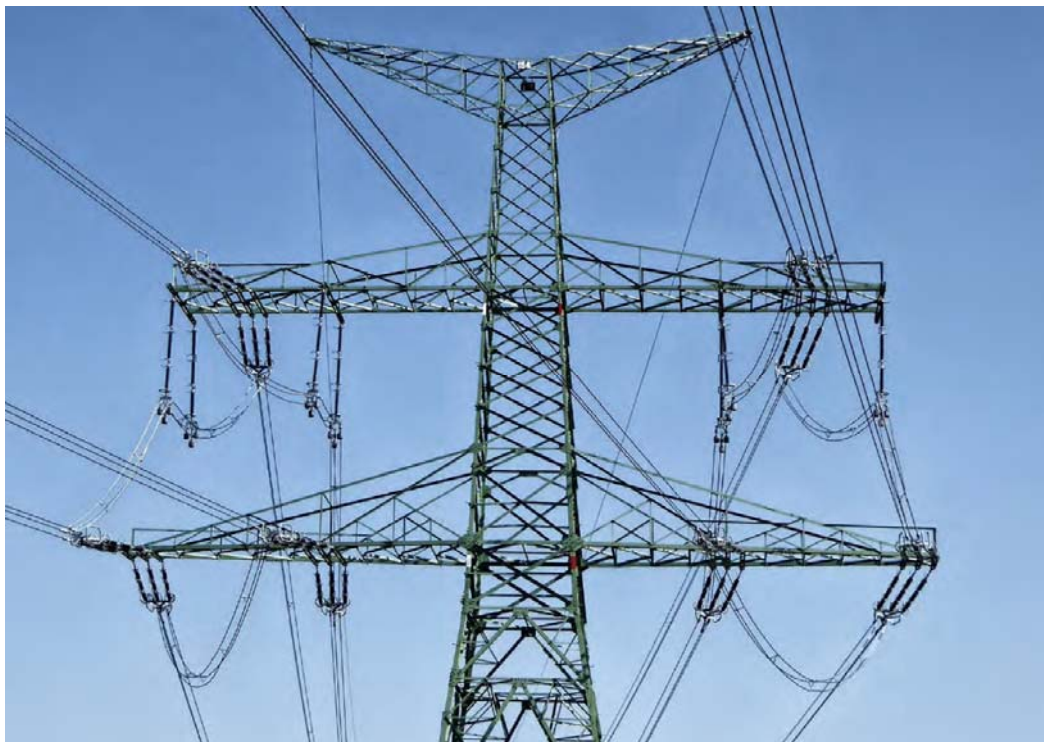
Donau – kotevní (2x400 kV) (závěsy TK a ZZ se závažím - keramika, transpozice všech FV, 2x ZL)
