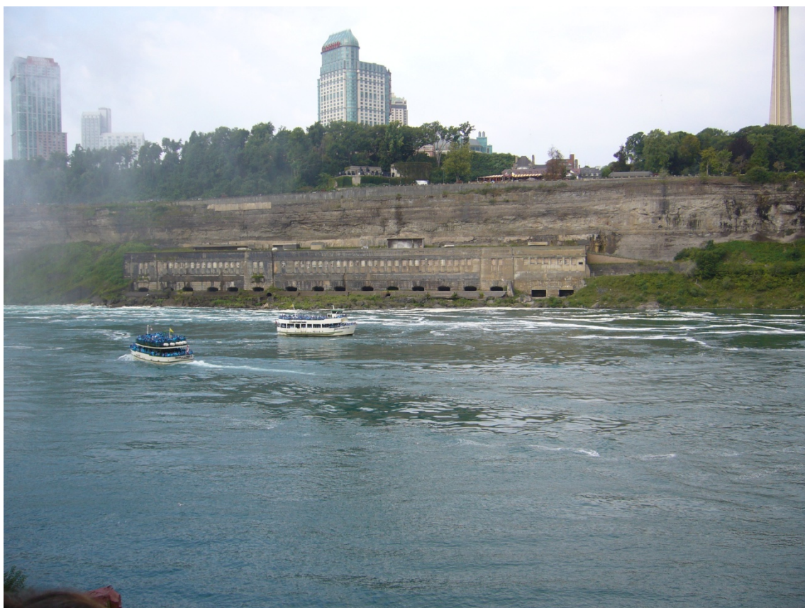
Obr. 1.3 Vodní elektrárna na řece Niagaře v USA
