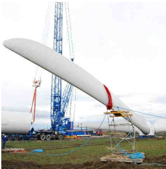
Obr. 5.3.1.1 Stavba vysoké větrné elektrárny - Pchery - výška 88 m, instalovaný výkon 3MW
