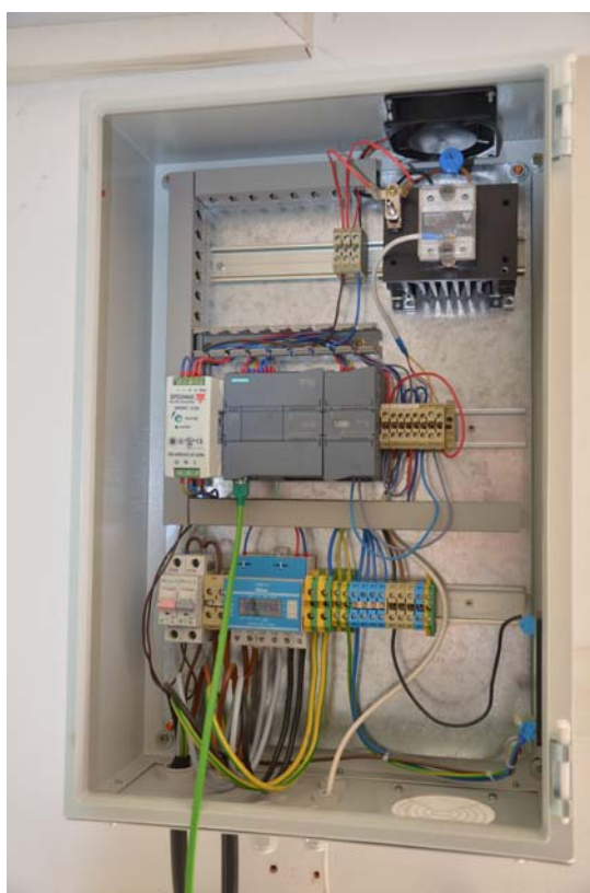
Obr. A.2: Rozvodná skříň pro fotovoltaiku
