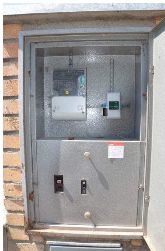
Obr. A.3: Čtyřkvadrantový elektroměr
