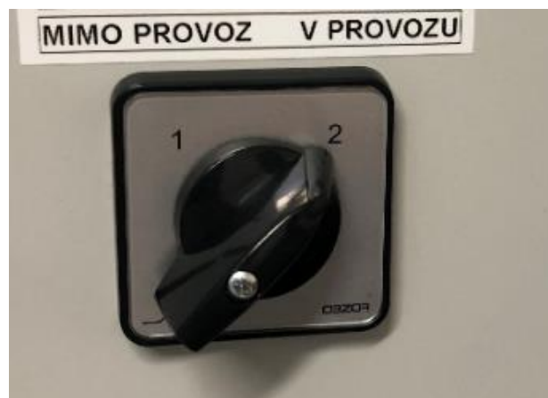
Obr. 3.2 Přepínač provozu pro zařízení PWC600
