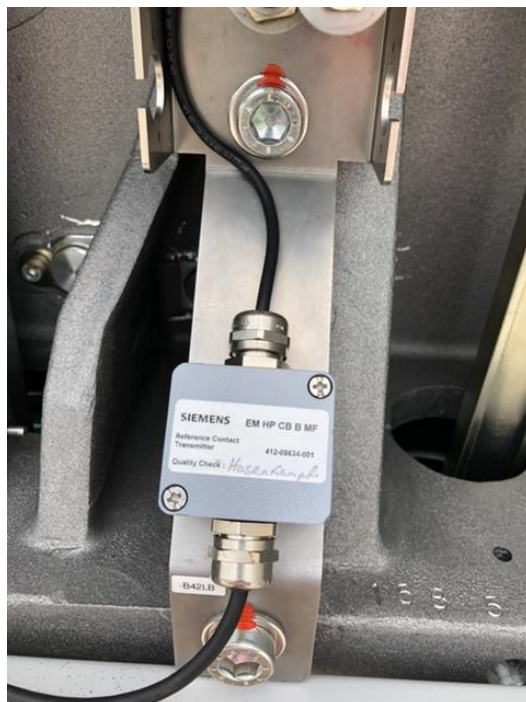
Obr. 3.8 Referenční kontakt vypínače
