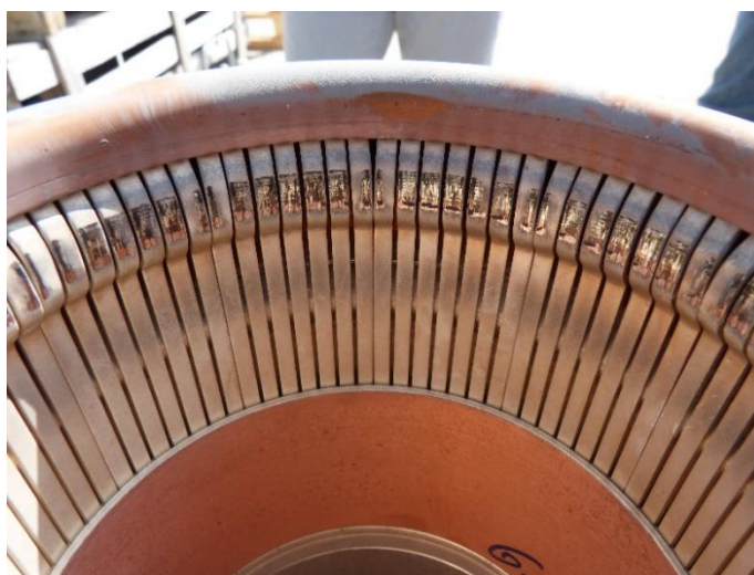
Obr. 2.9 Pohled na elektrické kontakty v komoře vypínače
