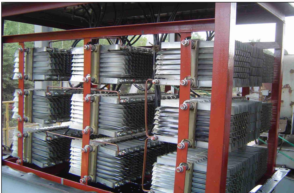
Obr. 2.1 Odporové bloky rotorového spouštěče SPD 3
