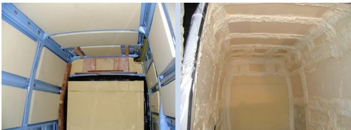
Obr. 2.4 Izolování metodou polyuretanových desek ITPUR D a stříkanou PUR pěnou [18]
