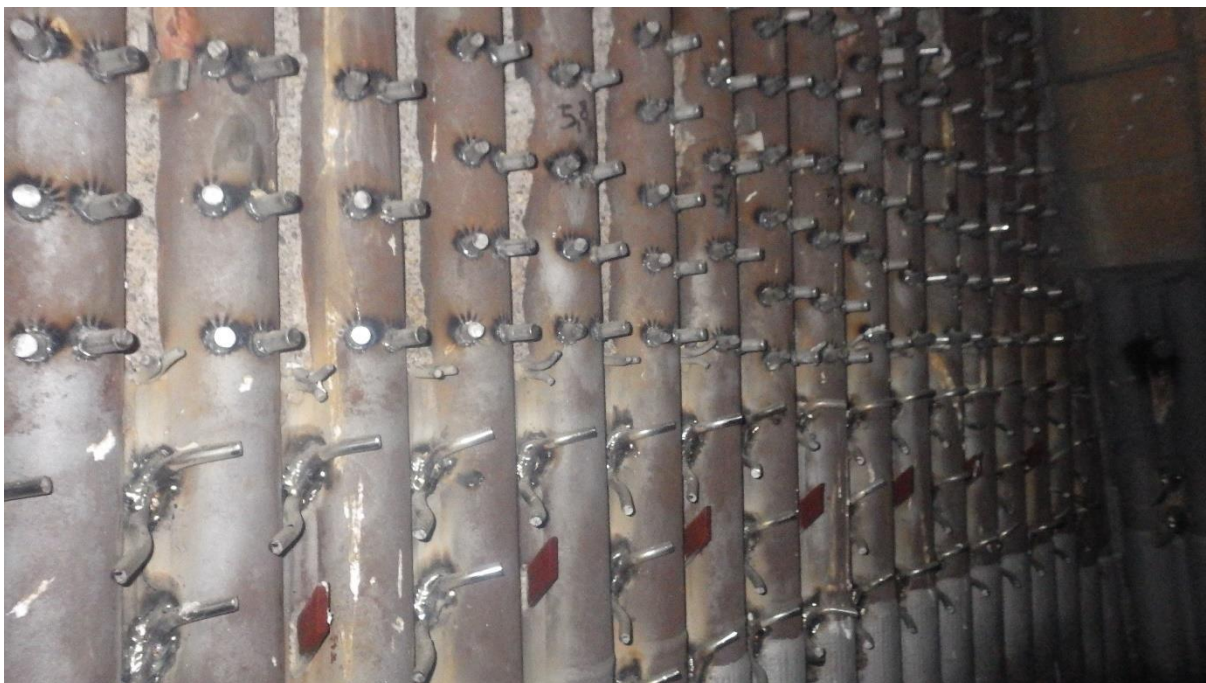
Obr.č. 10: Navaření kovových trnů na trubky výparníku.
