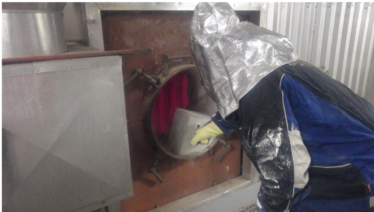
Obr.č. 12: Příprava pro čištění řízenou detonací. Otvírání revizních otvorů v horní části kotle za plného provozu.
