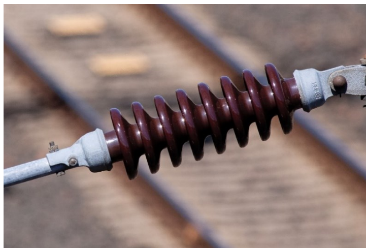
Obr. 1.8: Keramický tyčový izolátor – převzato [17]
