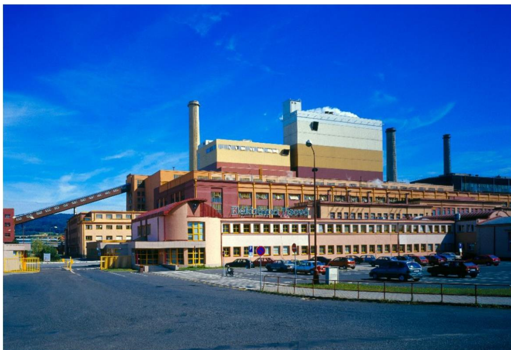
Obrázek č. 9: Elektrárna Tisová
